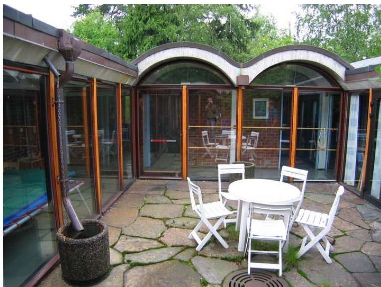
Indre lysgård i Steinstua. Opphavsrett: Statsbygg.
