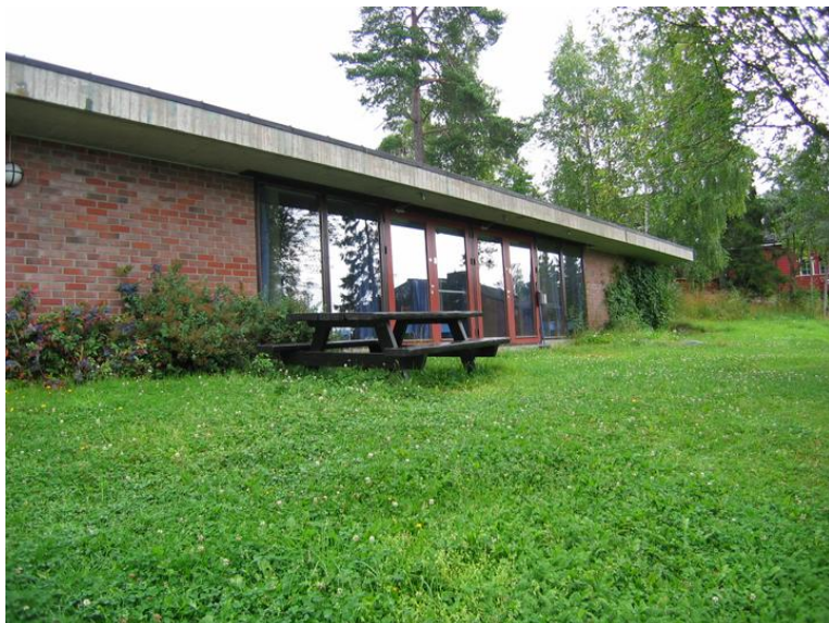
Sørfasaden med vinduer mot fellesrommet. Opphavsrett: Statsbygg
