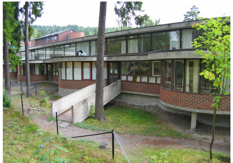
Sørfløyen mot vest. Opphavsrett: Statsbygg
