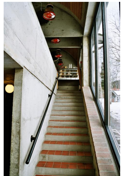
Bildet viser trappa opp fra underetasjen Foto: Magnus Torp Opphavsrett: Statsbygg
