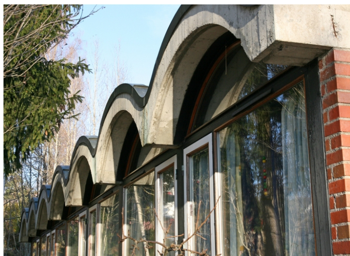
Ett internatrom for hver bue. Opphavsrett: Statsbygg.
