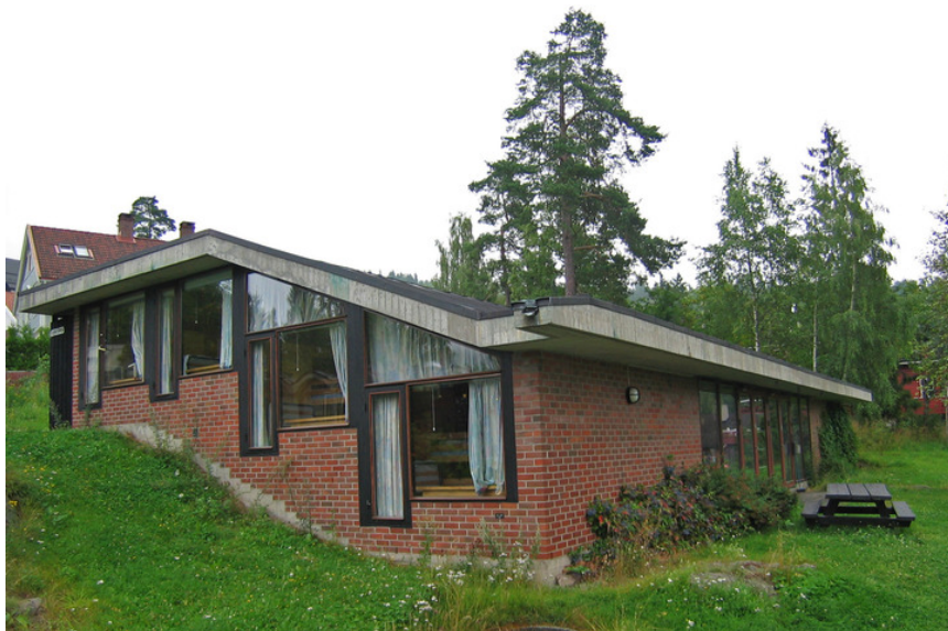
Ekorntoppen har svarte vindusrammer. Opphavsrett: Statsbygg.
