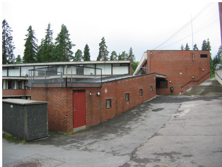
Forbindelse mellom fløyene. Opphavsrett: Statsbygg
