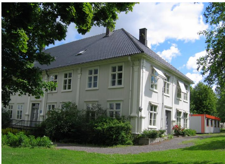
Hjørne nord/vest. Opphavsrett: Statsbygg.
