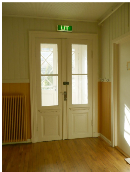
Gammel hoveddør. Opphavsrett: Statsbygg.
