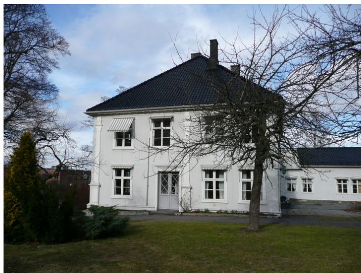
Fasade sørvest. Opphavsrett: Statsbygg.
