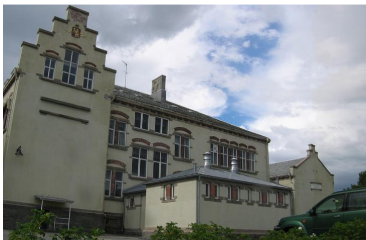
Fasade øst med original toalett-paviljong. Opphavsrett: Statsbygg.
