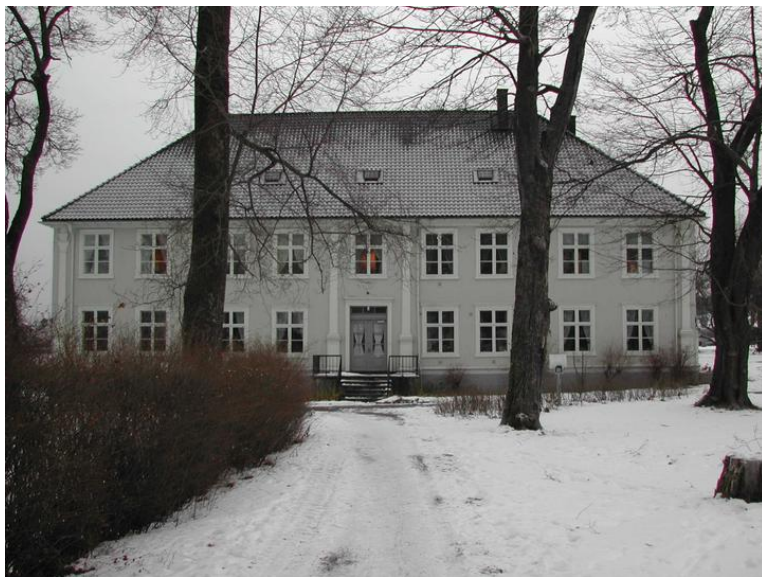
Gamle Gausen fasade nord. Opphavsrett: Statsbygg.
