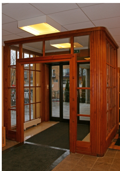
Hovedinngangens vindfang Opphavsrett: Statsbygg
