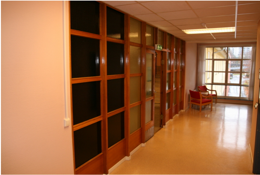
Glassfelt mellom hall/trapperom og internatfløy. Opphavsrett: Statsbygg
