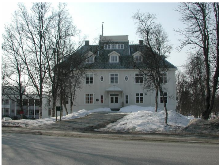
Fasade nord - sett fra Langnesveien
