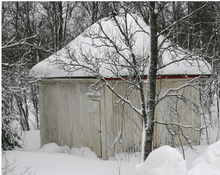
Magnethus. Opphavsrett: Statsbygg
