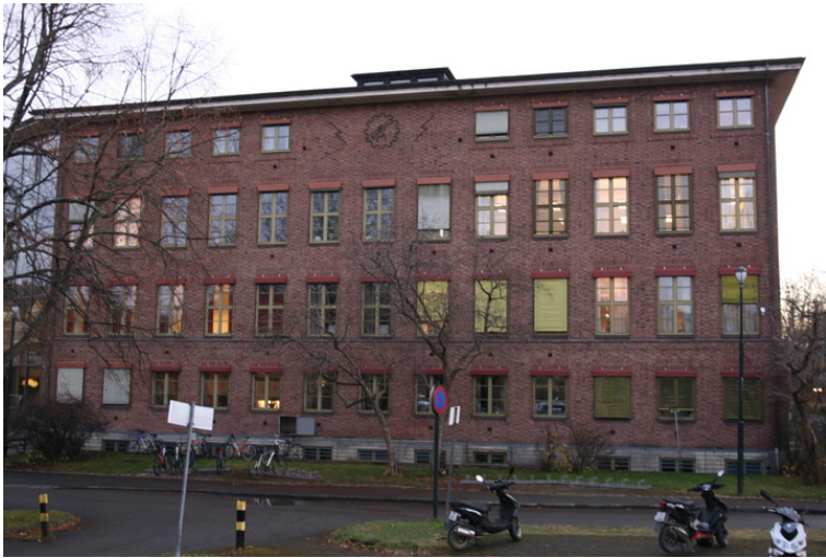
Hovedfasaden til 1930-delen er nokså opprinnelig. Opphavsrett: Statsbygg
