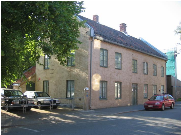
Fasade mot Sverresgate. Opphavsrett: Statsbygg
