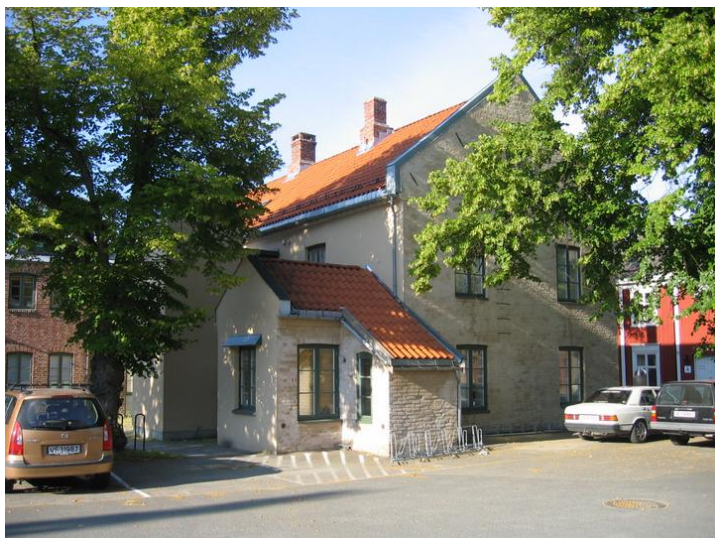
Fasade mot gårdrommet. Opphavsrett: Statsbygg
