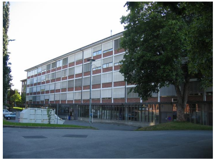
Fasade mot gårdsrommet, 1962-delen. Opphavsrett: Statsbygg
