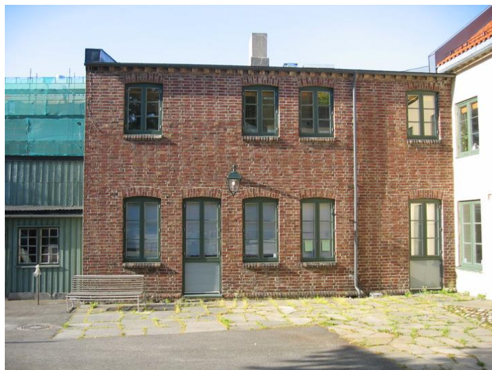
Sidebygningens fasade inn mot gårdrommet. Det har opprinnelig vært to utgangsdører, disse er nå erstattet med vinduer. Opphavsrett: Statsbygg
