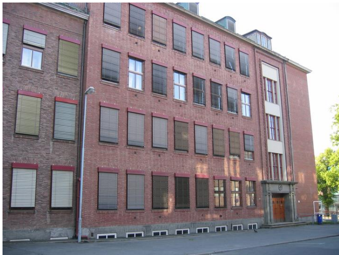
Fasade mot Sverresgate med tilbygget fra 1938 til høyre. Opphavsrett: Statsbygg
