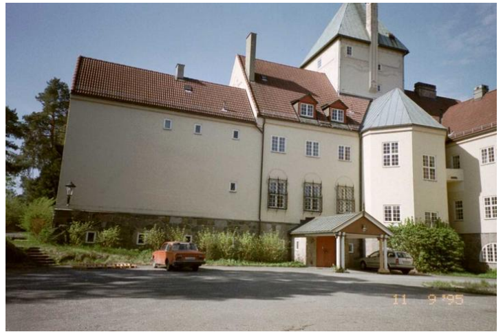
Nordfasade, hovedfløy og østfløy. Opphavsrett: Statsbygg.
