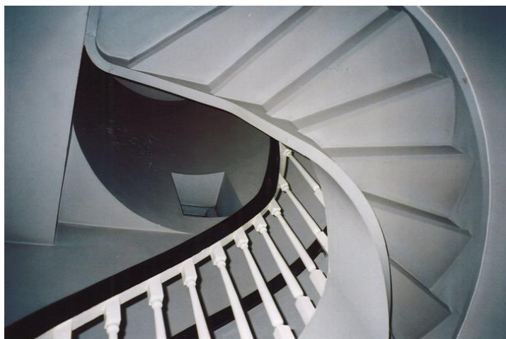
Trappen opp i tårnet er i tre. Foto: Siri Hoem Opphavsrett: Oslo kommune, Byantikvaren
