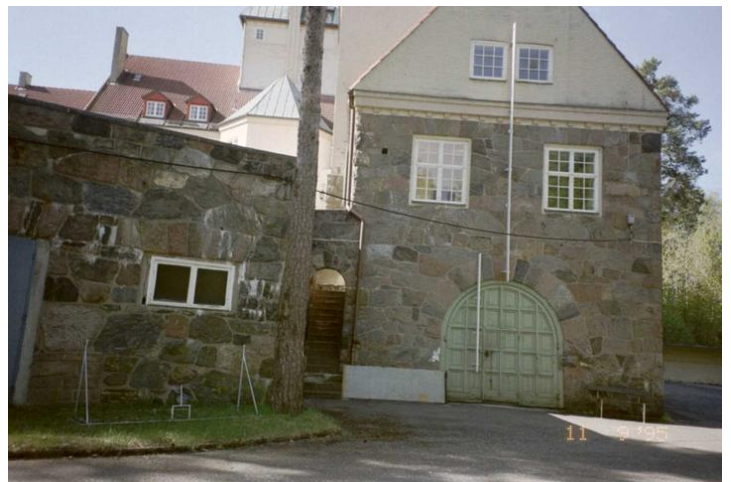
Nordfasade, vestfløy. Opphavsrett: Statsbygg.
