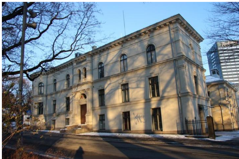
Sørvestre fløy hvor opprinnelig Statistisk sentralbyrå hadde sine lokaler. Opphavsrett: Statsbygg.
