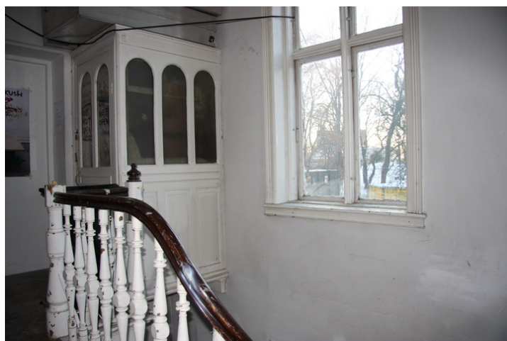
På toppen av trappa mellom 1. og 2. etasje er et lite rom vi ikke vet funksjonen til. Opphavsrett: Statsbygg.
