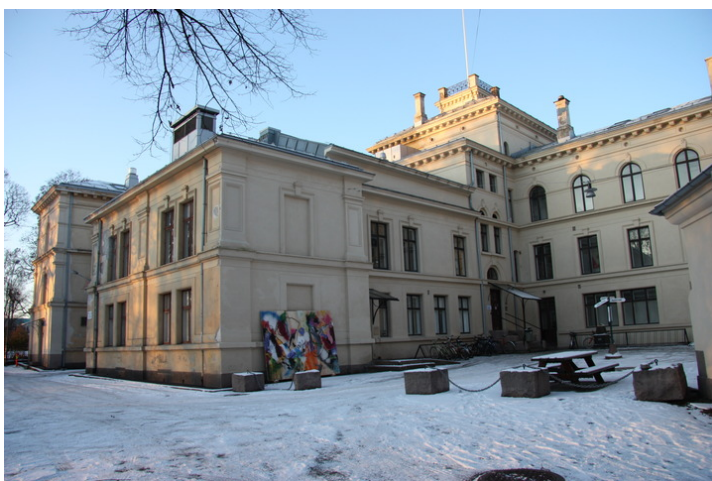
En bred midtfløy vender inn mot indre gårdsrom. Opphavsrett: Statsbygg.
