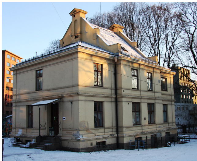
Annekset med vest- og sørvegg mot gårdsrom og hage. Opphavsrett: Statsbygg.
