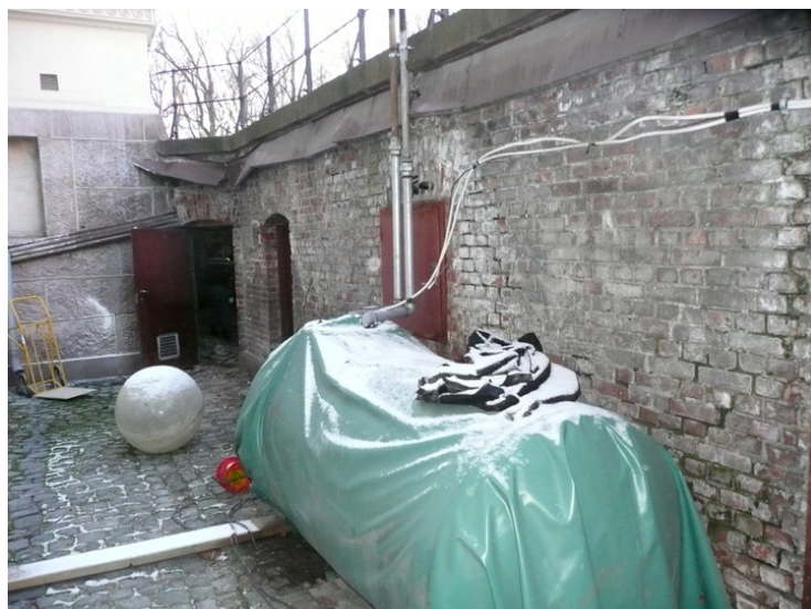
Lyssjakter og kulverter på hver side av hovedinngangen. Opphavsrett: Statsbygg.
