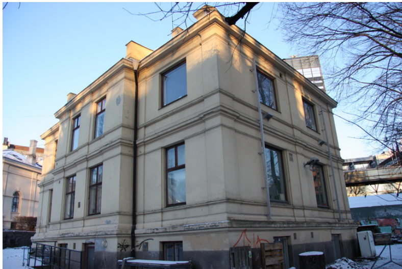
Annekset med sør- og østvegg. Opphavsrett: Statsbygg.
