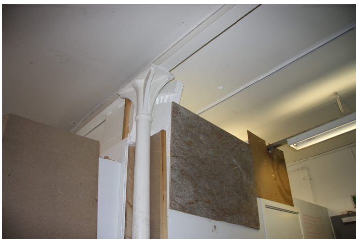
Stålbjelker i 1. etasje. Opphavsrett: Statsbygg.
