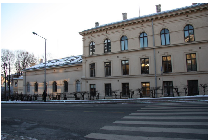
Nordre fløy med skulptursal til venstre. Opprinnelig spesialbygget for plasskrevende trykkepresser med "tørkesal" på loftet. Opphavsrett: Statsbygg.
