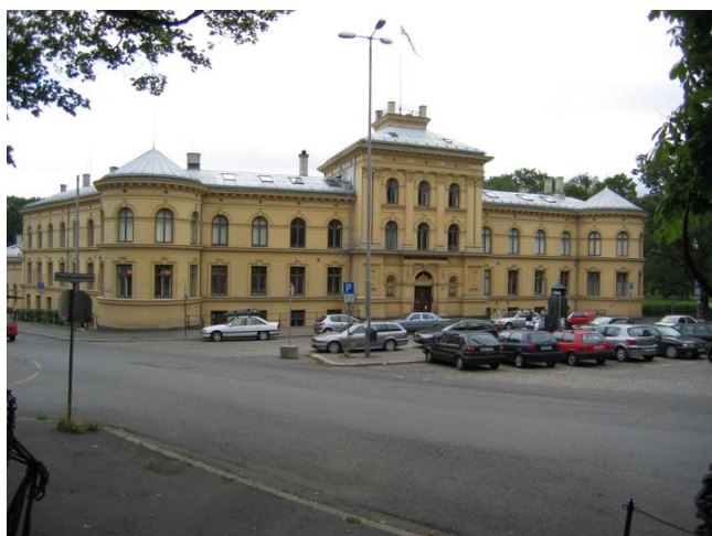
Fasade mot nord og vest. Opphavsrett: Statsbygg.
