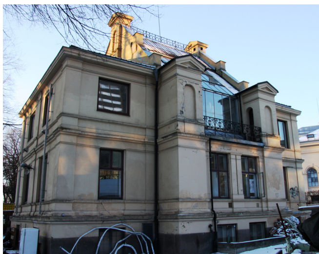
Fasade mot St. Olavs gt. med dagslysatelier. Opphavsrett: Statsbygg.
