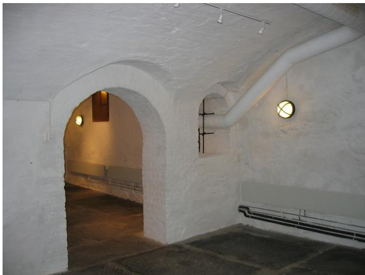
Kjelleren var opprinnelig delt i to rom med kraftig dør mellom rommene. Vinduslugger med jerngitter. Opphavsrett: Statsbygg
