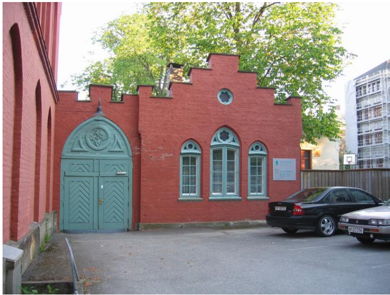
Garasjebygningens gavl mot Bispegata med port til gårdsrommet. Opphavsrett: Statsbygg
