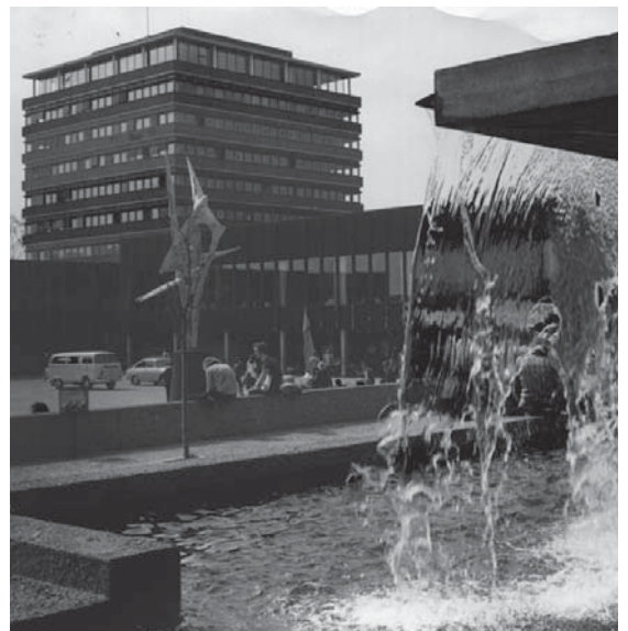
Administrasjonsbygningen sett fra nordøst. Opphavsrett: UiO.
