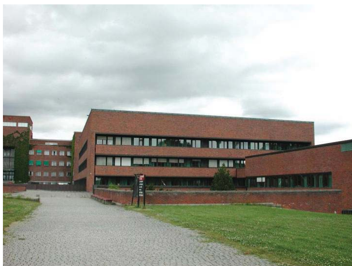
Østre kjemibygning, fasade mot sør. Opphavsrett: UiO.
