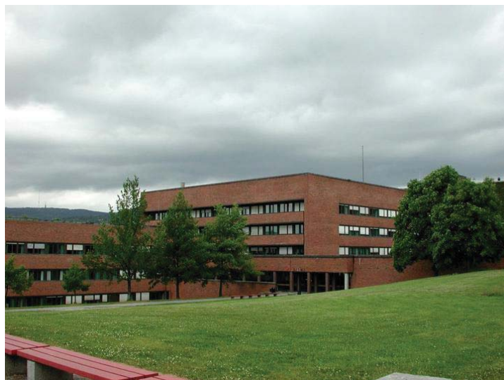
Vestre kjemibygning, fasadeutsnitt. Opphavsrett: UiO.
