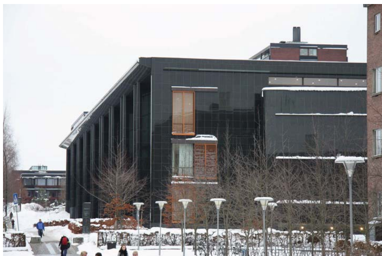
Georg Sverdrups hus - universitetsbiblioteket. Opphavsrett: Statsbygg.
