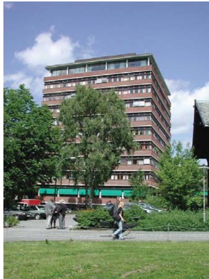
Administrasjonsbygningens sydfasade. Opphavsrett: UiO.
