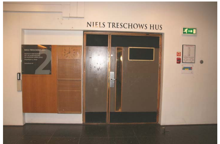
Dører fra trapperom til 2.etg. Opphavsrett: Statsbygg.
