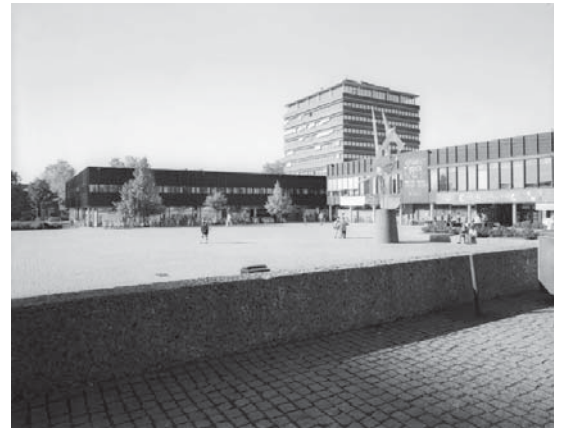
Frederikke sett fra nordøst, med Lavblokk (BL02) til venstre og Administrasjonsbygningen (BL01) i bakgrunnen. Opphavsrett: UiO.
