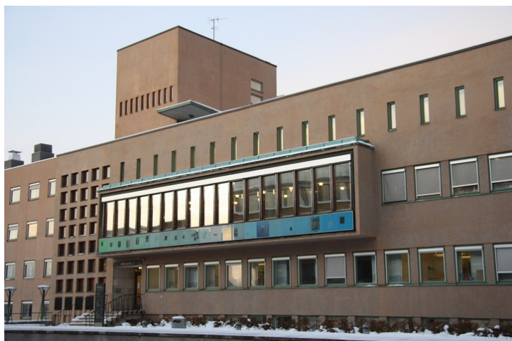
Opprinnelig hovedinngang med kantinen utkraget i 2. etg. Opphavsrett: Statsbygg
