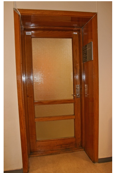
Opprinnelig dør mot resepsjonen. Opphavsrett: Statsbygg.
