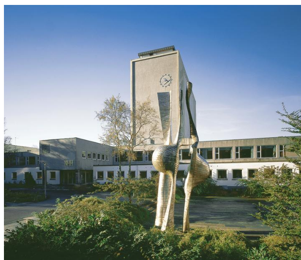
Hovedinngang/høyblokken. Opphavsrett: NHH.
