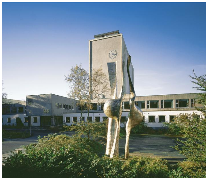
Hovedinngang/høyblokken. Opphavsrett: NHH.
