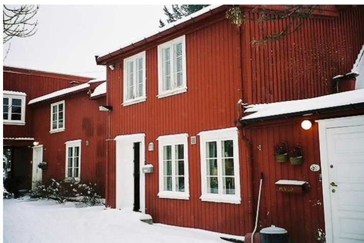
Inngangsfasade mot nord. Foto: Tom Wassum
