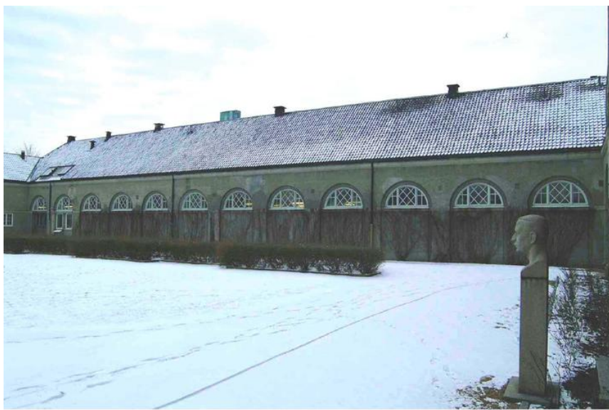
Fasade mot parken. Foto: Tom Wassum
