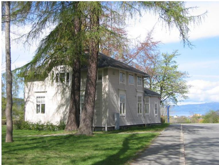
Infohuset Foto: Arne Rønning. Opphavsrett: NTNU.
