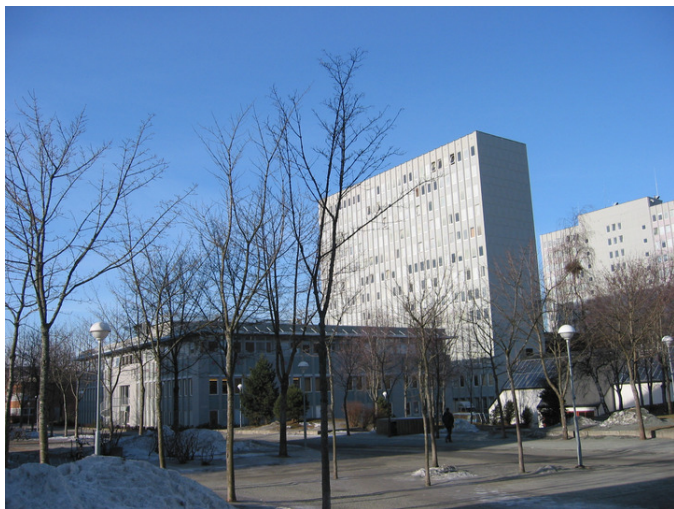
Sentralbygg 1 sett fra øst. Opphavsrett: NTNU.
