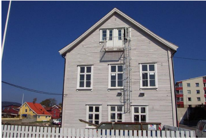
AN 02 Tollboden - fasade mot syd. Opphavsrett: UiO.
