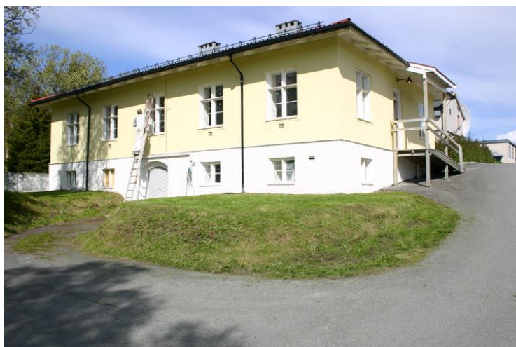
Obs.hus sett fra syd/øst Opphavsrett: Teknisk avd. UiTø
