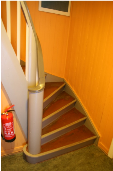
Trapp opp til 2. etg. i den vestlige delen. Opphavsrett: Statsbygg.
