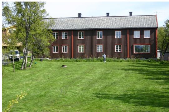
Fasade mot syd Opphavsrett: Teknisk avd. UiTø
