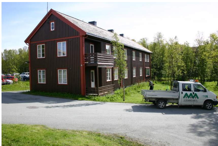
Gavlfasade mot vest. Opphavsrett: Teknisk avd. UiTø
