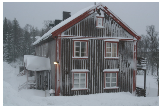
Funksjonærbolig. Opphavsrett: Statsbygg.
