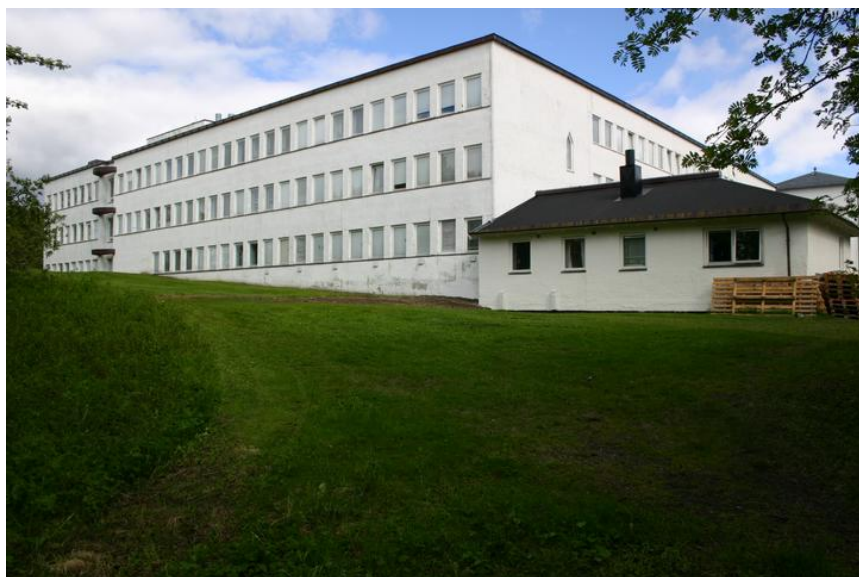
Bakfasade (kontorer og vaktmesterfløy). Opphavsrett: Teknisk avd. UiTø.
