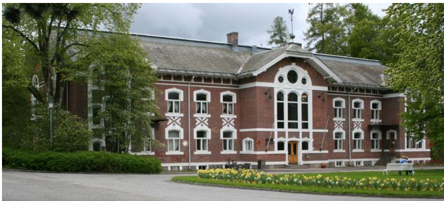
Økonomibygningens nordfasade mot tunet. Foto: J.Chr. Eldal, NIKU 2006.
