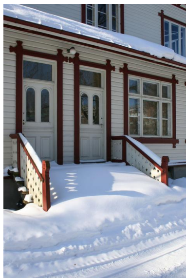
Damsgård sett fra øst. Kjøkkeninnganger med trapp fornyet i oppr. formspråk. Foto: J.Chr. Eldal, NIKU 2006.
