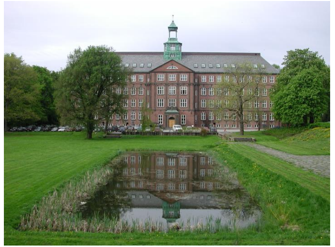
Tårnbygningens østfasade. Foto: Bjørn Anders Fredriksen, UMB.
