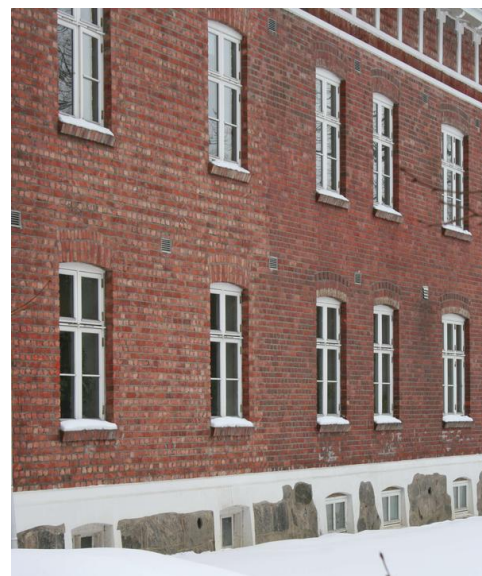
I Tivolis nordfasade ses skillet mellom Holtermanns del t.h. og Sverres forlengelse t.v. Foto: J.Chr. Eldal, NIKU 2006.
