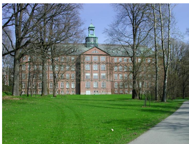
Tårnbygningens vestfasade. Foto: Bjørn Anders Fredriksen, UMB.
