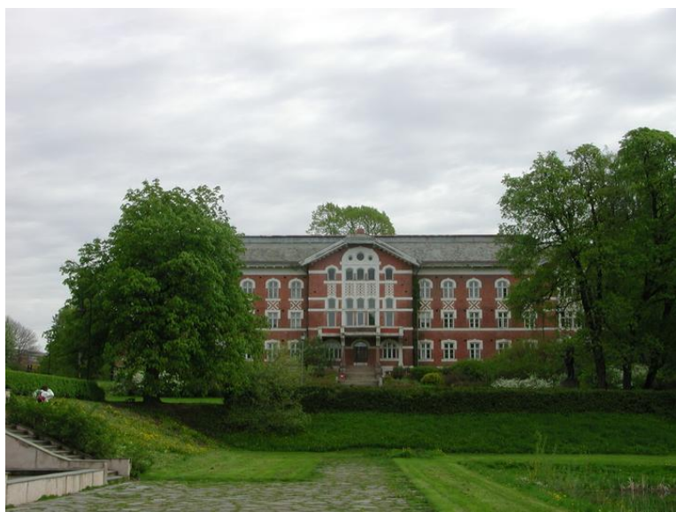
Cirkus, fasade mot vest, sett fra parken. Foto: Bjørn Anders Fredriksen, UMB.
