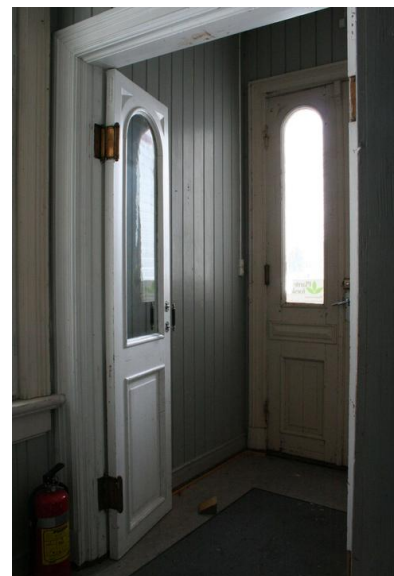
Østre vindfang sett mot øst. Foto: J.Chr. Eldal, NIKU 2006.
