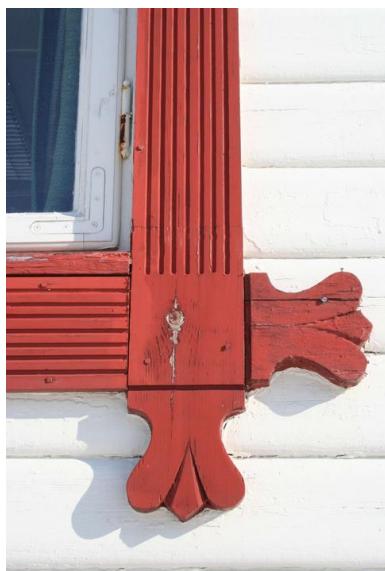
På de søndre fasadene er vinduer og gerikter delvis skiftet ut. Foto: J.Chr. Eldal, NIKU 2006.
