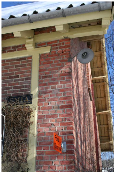
Søndre hjørne 2006. Spor i bindingsverk og mur viser at deler av bindingsverket er fjernet og sørøstre gavlvegg ommurt. Foto: J.Chr. Eldal, NIKU 2006.
