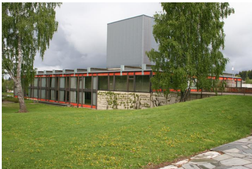
Aud. Max. sett fra Studentsamfunnets terrasse i sørøst med forbindelsesbygget t.h. Foto: J.Chr. Eldal, NIKU 2006.
