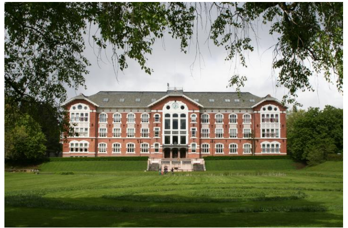
Urbygningens hovedfasade mot Storeplenen i sør. Foto: J.Chr. Eldal, NIKU 2006.
