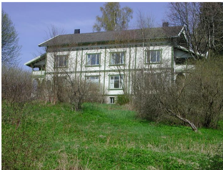
Fougnerbakken 18-20, sett fra vest.
