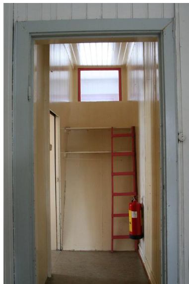
I gangen ved kjøkkenet i 1. etasje slippes lyset inn over den innbygde kjellertrappen. Foto: J.Chr. Eldal, NIKU 2006.
