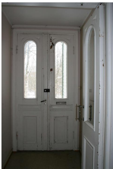
Østre vindfang sett mot nord. Foto: J.Chr. Eldal, NIKU 2006.
