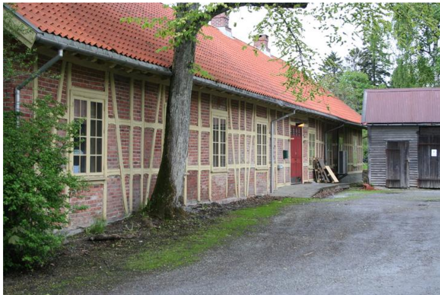
Smias østfasade med nyere garasje t.h. Foto: J.Chr. Eldal, NIKU 2006.
