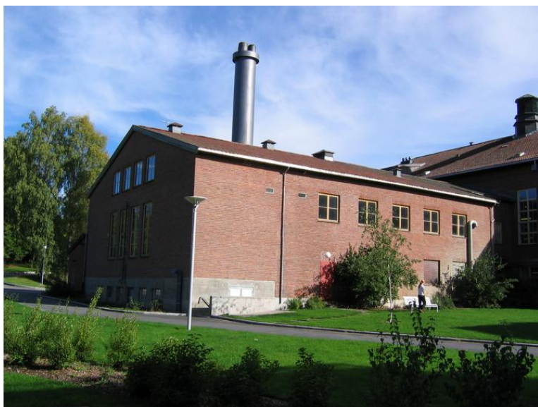
Varmesentralen Foto: Bjørn Anders Fredriksen
