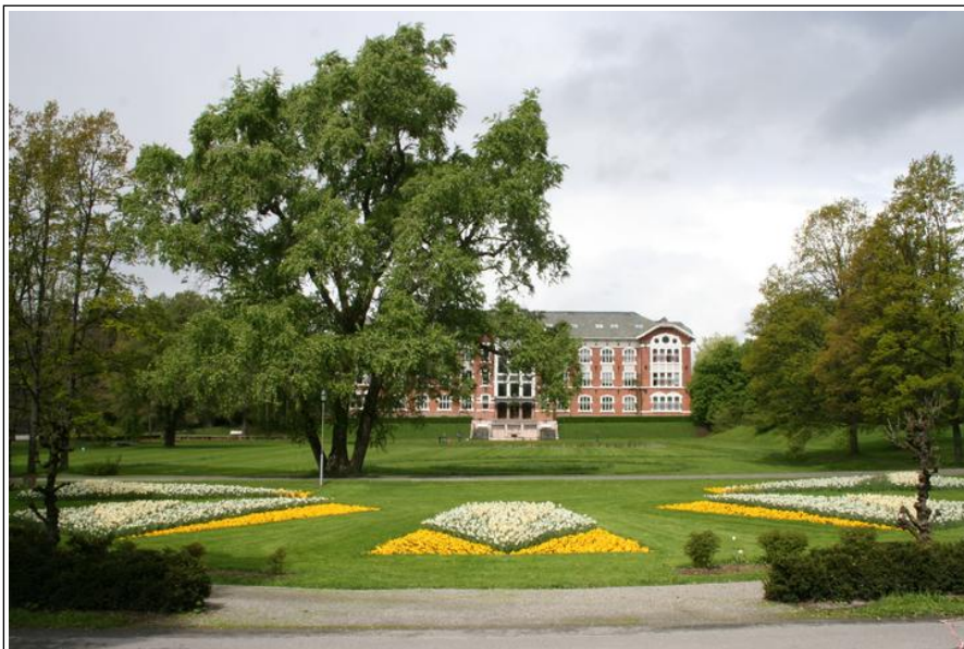
Storeplenen med Urbygningen. Foto: J.Chr. Eldal, NIKU 2006.
