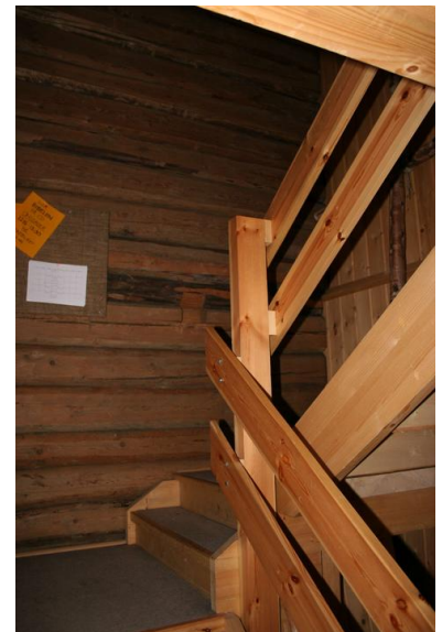
Trapp fra 1979. Spor i veggen viser at deler av gulvet i 2.etg. ble fjernet for å gi plass til trappen. Foto: J.Chr. Eldal, NIKU 2006.
