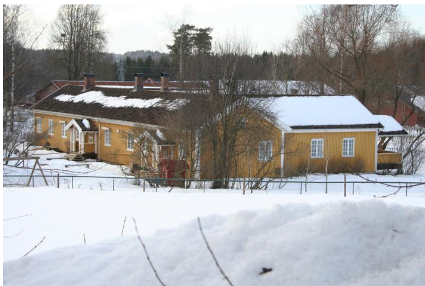
Åkebakke barnehage sett fra sørøst. Oppr. bygning fra 1919 t.v. og sidefløy tilbygget 1992 t.h. Foto: J.Chr. Eldal, NIKU 2006.
