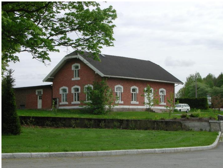
Konserveringa sett fra vest. Foto: Bjørn Anders Fredriksen, UMB.
