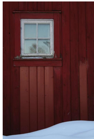
Ved reparasjon av panelet på nordøstveggen er bare enkelte bord skiftet ut. Foto: J.Chr. Eldal, NIKU 2006.
