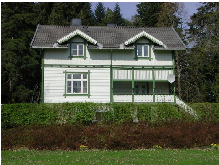
Fougnerbakken 16, sørfasade. Hagetrappen er flyttet fra oppr. plass i verandaens midtakse, og verandafronten har mistet bueknær i sidefeltene og høy bueåpning i midten. Foto: Bjørn Anders Fredriksen.
