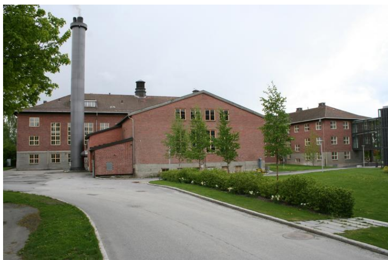
Meieriinstituttet sett fra nord med varmesentralen i forgrunnen og forbindelsesgangen til Bioteknologibygget t.h. Foto: J.Chr. Eldal, NIKU 2006.
