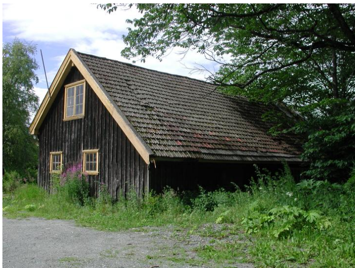
Redskapshuset sett fra nordøst Foto: Bjørn Anders Fredriksen
