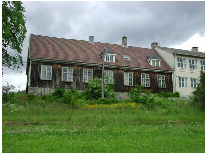
Semsvn. 168, den gamle vevstua, sydfasade Foto: Bjørn Anders Fredriksen. Opphavsrett: UMB.
