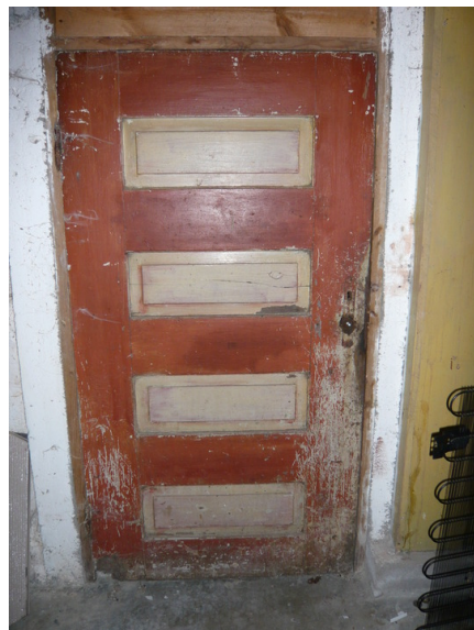
Dør i kjelleren. Opphavsrett: Statsbygg.
