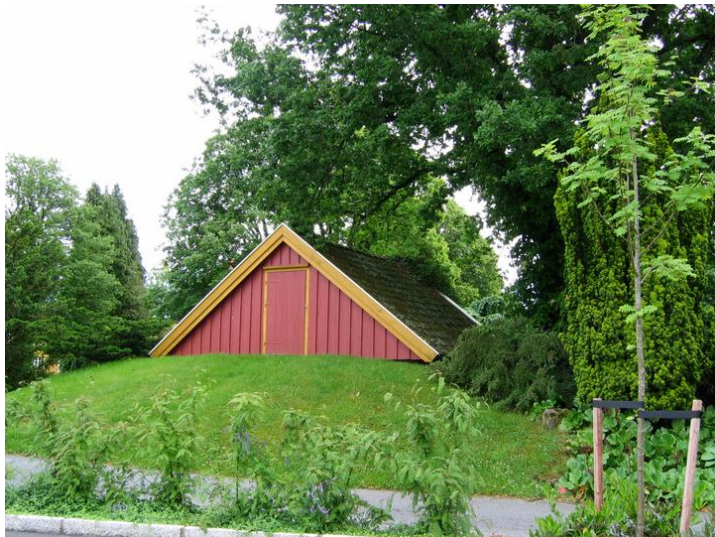
Vestfasaden hvor kun loftsrommet synes. Foto: Lasse Kaas Opphavsrett: Statsbygg
