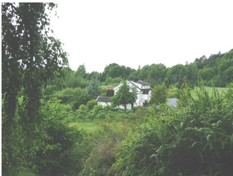
Bygg U og V sett fra vest Foto: Lasse Kaas Opphavsrett: Statsbygg
