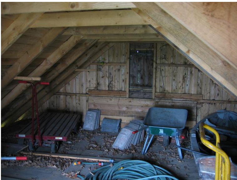
Loftsrom med eksponerte bærende konstruksjoner Foto: Lasse Kaas Opphavsrett: Statsbygg
