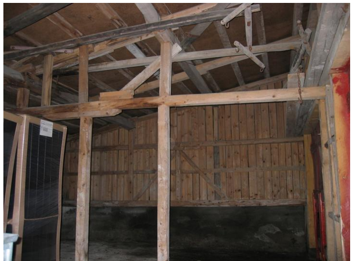
Interiør i garasjen Foto: Lasse Kaas Opphavsrett: Statsbygg
