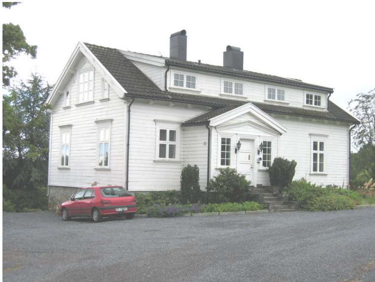
Nordfasade Opphavsrett: Statsbygg
