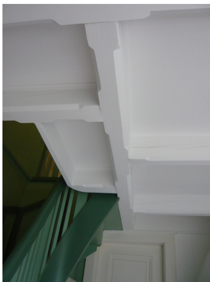
Tak i 1.etg. Opphavsrett: Statsbygg.
