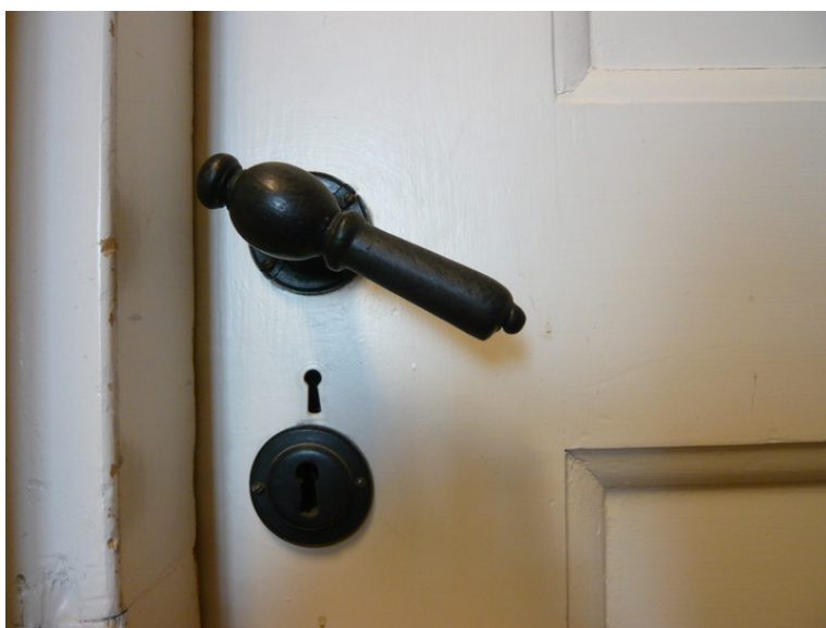
Opprinnelige dørvidere fortsatt i bruk. Opphavsrett: Statsbygg.
