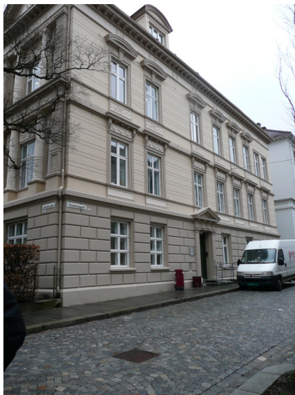
Ørjan Øyens hus. Opphavsrett: Statsbygg.
