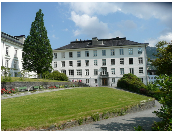
Østfløy Jahnebakken 3, gamle kjemisk institutt. Opphavsrett: Statsbygg.
