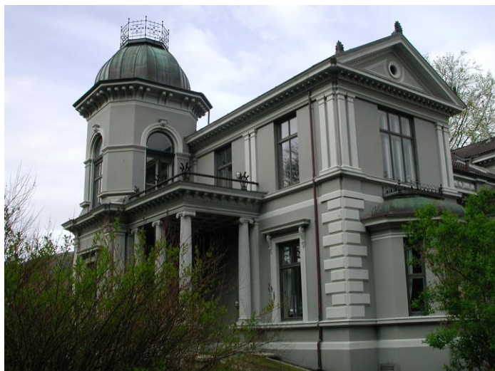
Villaveien 9, fasade mot nord-øst.
