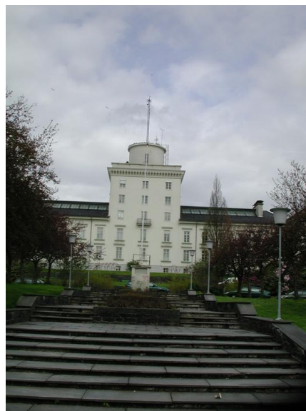
Allégaten 70 sett fra sør. Foto: Jostein Nyseth Opphavsrett: UiB.
