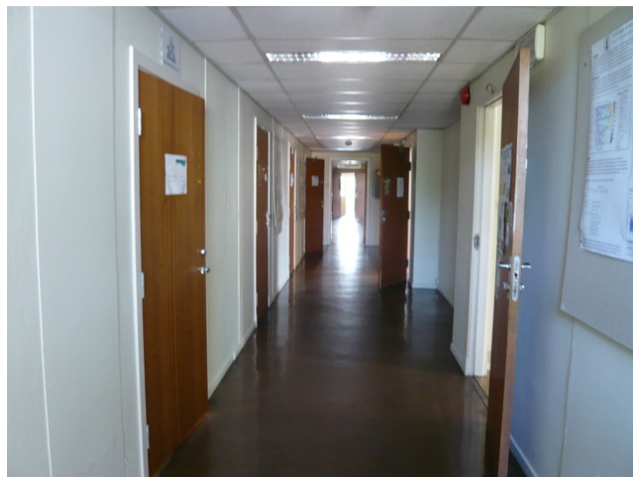
Korridor tredje etasje, med lyse malte vegger, linoleumsbelegg på gulvet samt enkle dører i lys eik. Opphavsrett: Statsbygg.
