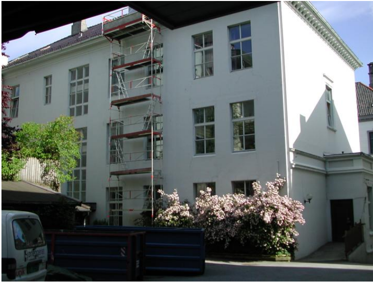
Rossenbergs-gaten 35. Fasade mot sør, inn mot bakgård Foto: Jostein Nyseth. Opphavsrett: UiB.
