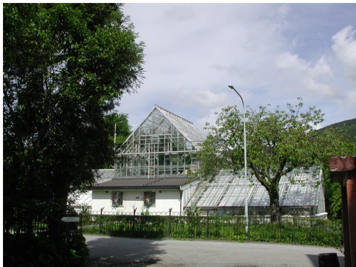
Fasade mot vest Opphavsrett: UiB.
