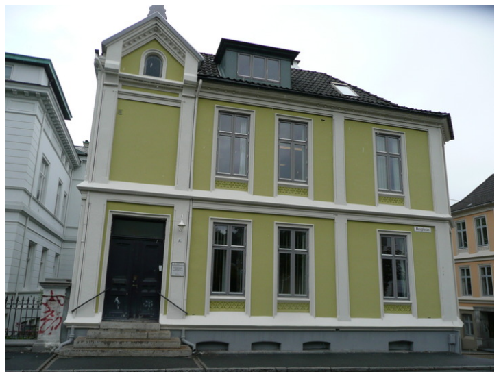
Muséplass 2. Opphavsrett: Statsbygg.
