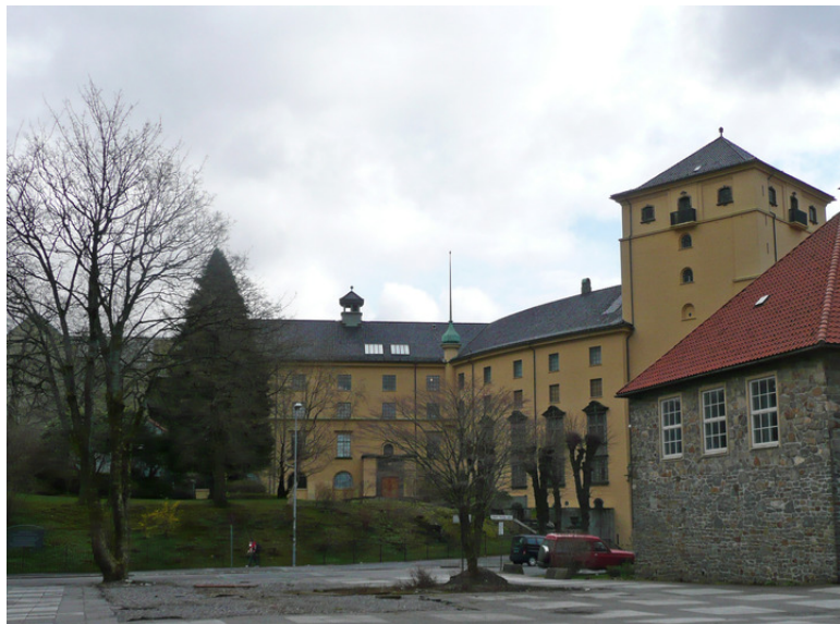
Fasade mot nord-øst. Opphavsrett: Statsbygg.
