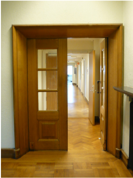
Korridor nne etasje med eikedører mot vestibulen og malte furudører i selve korridoren. Opphavsrett: Statsbygg.
