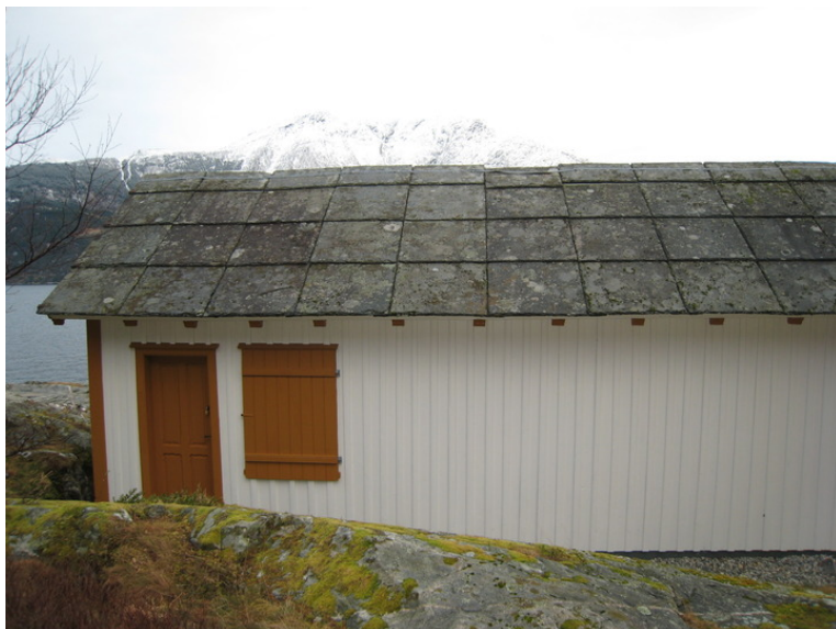
Naust. Vestfasade. Opphavsrett: UiB.
