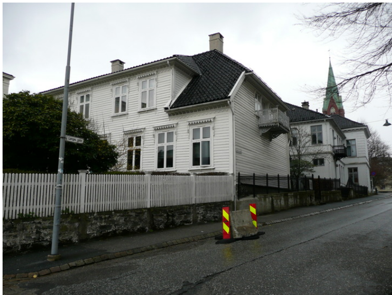
Langesgt. 3. Opphavsrett: Statsbygg.
