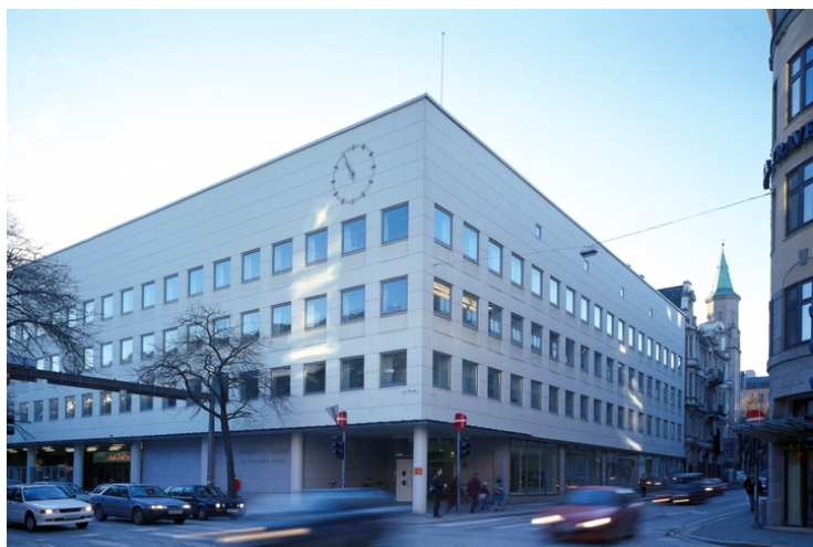
CHRISTIESGT 12 Opphavsrett: Statsbygg
