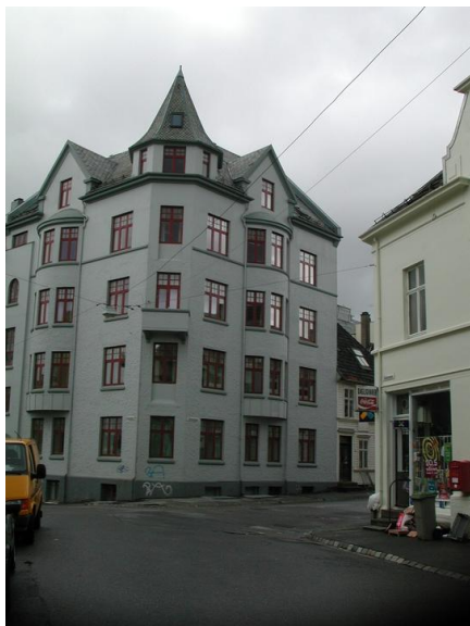
Dokkeveien 2B, fasade mot nord-vest. Opphavsrett: UiB.
