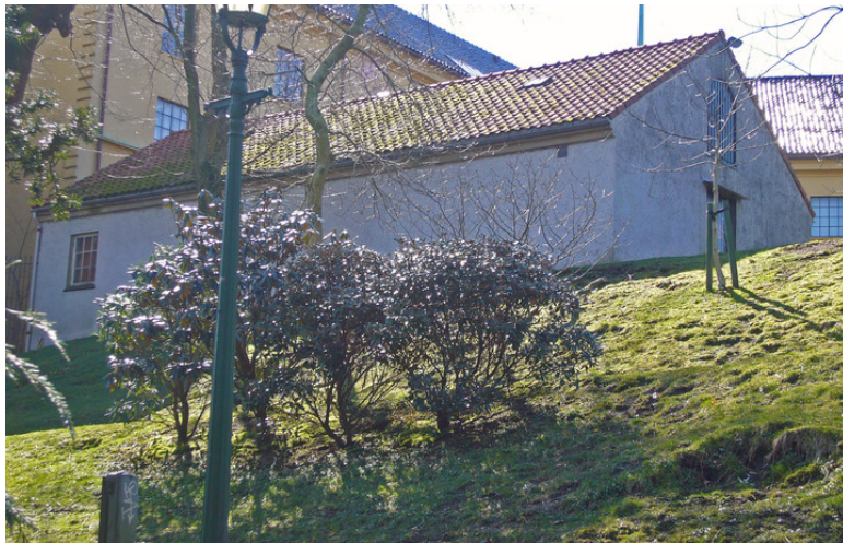
Magsinbyggets nordøstre fasade. Opphavsrett: Statsbygg.
