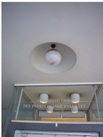
Lamper inngangshall. Opphavsrett: Statsbygg.
