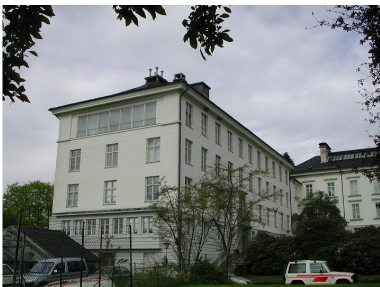
Jahnebakken 5, fasade mot sør-øst. Foto: Jostein Nyseth Opphavsrett: UiB
