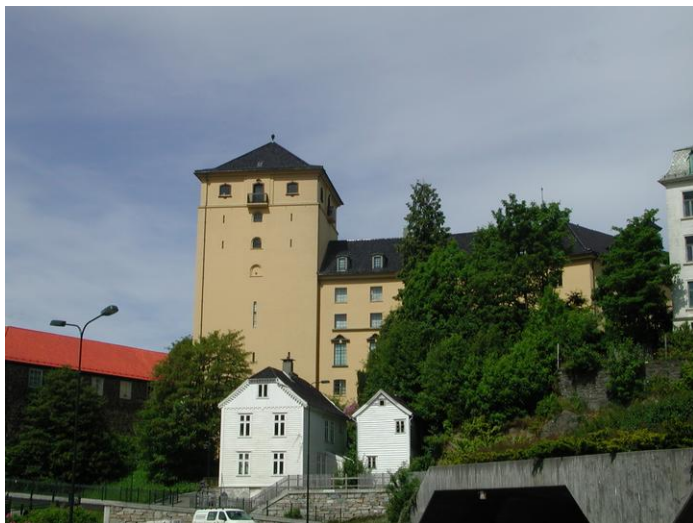
Fasade mot vest. Foto: Jostein Nyseth Opphavsrett: UiB.
