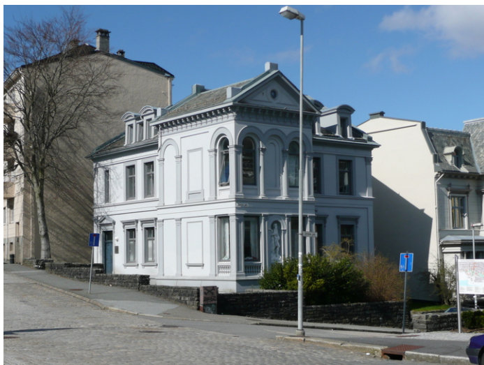
Christiesgt. 19. Opphavsrett: Statsbygg.
