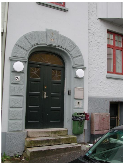
Dokkeveien 2B, hovedinngang Foto: Jostein Nyseth. Opphavsrett: UiB.
