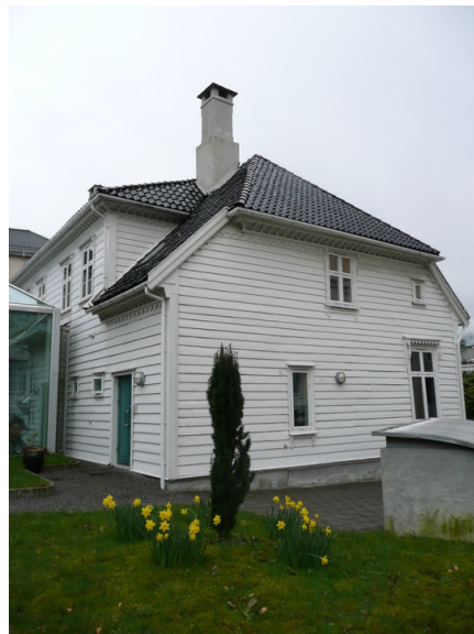
Langesgt. 3. Opphavsrett: Statsbygg.
