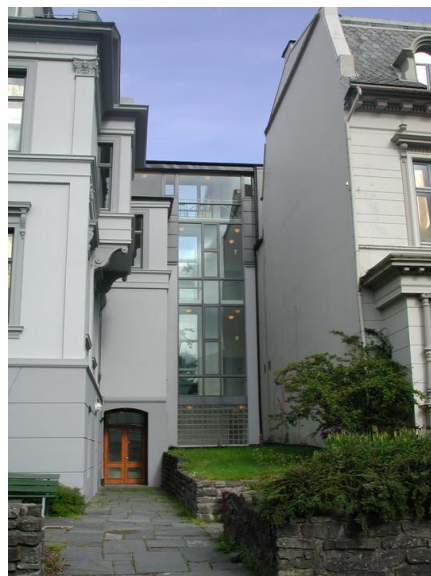
Christies gate 17 og 19, forbindelse mellom byggene. Foto: Jostein Nyseth
