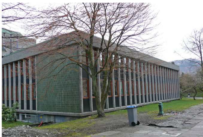
Deler av fasaden er kledd med keramiske fliser. Her sett fra øst. Opphavsrett: Statsbygg.
