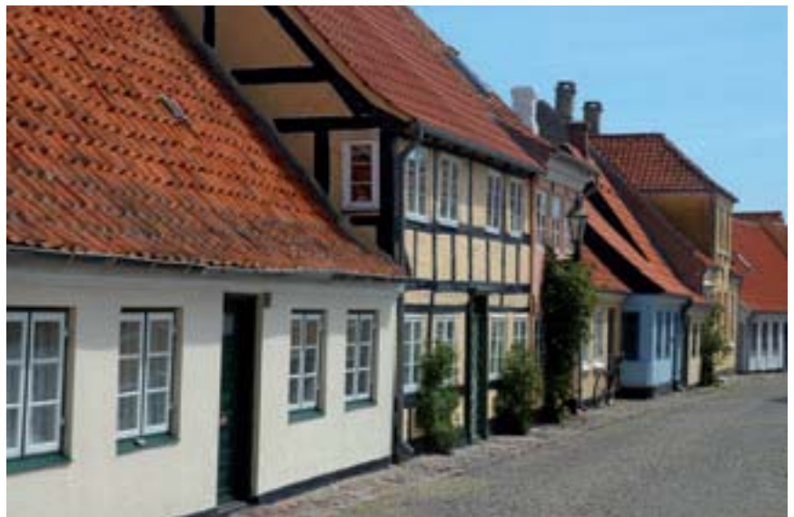
Ærøskøbing er en eldre dansk kjøpstad med cirka 40 gamle bygninger som stammer fra 1700-tallet, og som er fredet (foto: Stig Bachmann Nielsen/Naturplan).
