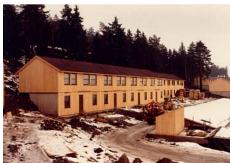
Bilde 1: Oversikt rekkehusfelt. U.etg. med støpt bakvegg og gavl.
