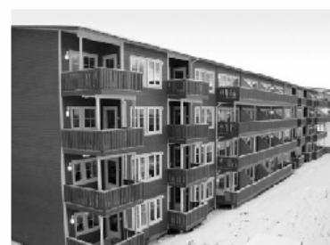
Boligblokk i Bodø. Først heises elementene på plass og så ser vi den ferdige blokka
