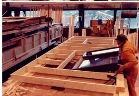
Bilde 4: Ytterveggelement. Innmontering av vindu.
