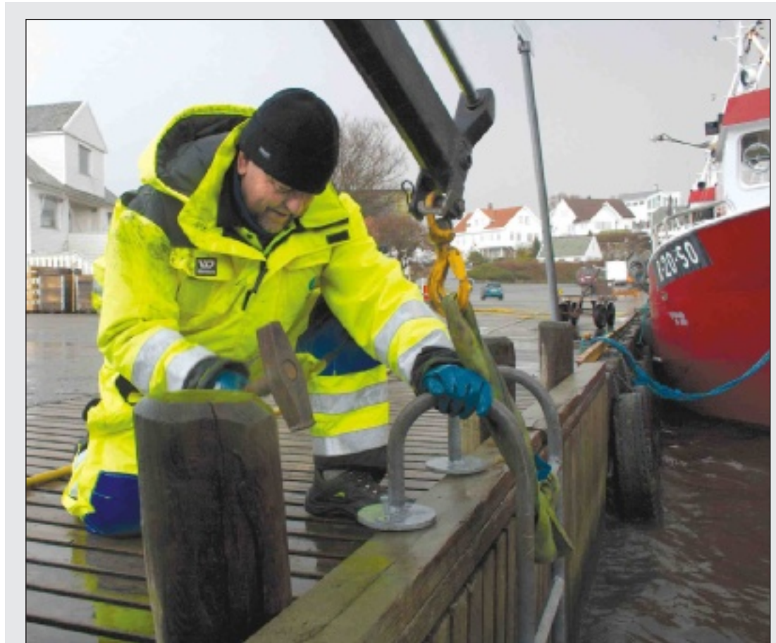
Tananger indre havn er Stavanger Interkommunale Havn IKS sitt ansvar. Nå setter de opp nye redningsstiger. (Foto: Line Viste)
