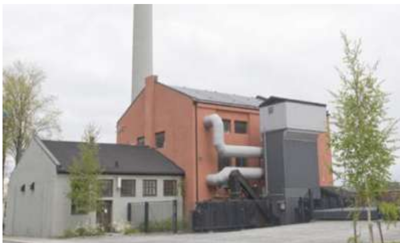
Marienborg varmesentral – Allskog skal levere masse virke til varmecentralen (Kilde: www.norsk-skogbruk.no )
