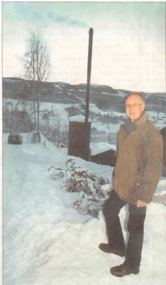
Rein biovarme: Ordfører Torleif T. Dalseide kan stolt konstatere at fyringsanlegget i skulesenteret i Ål er i drift.
