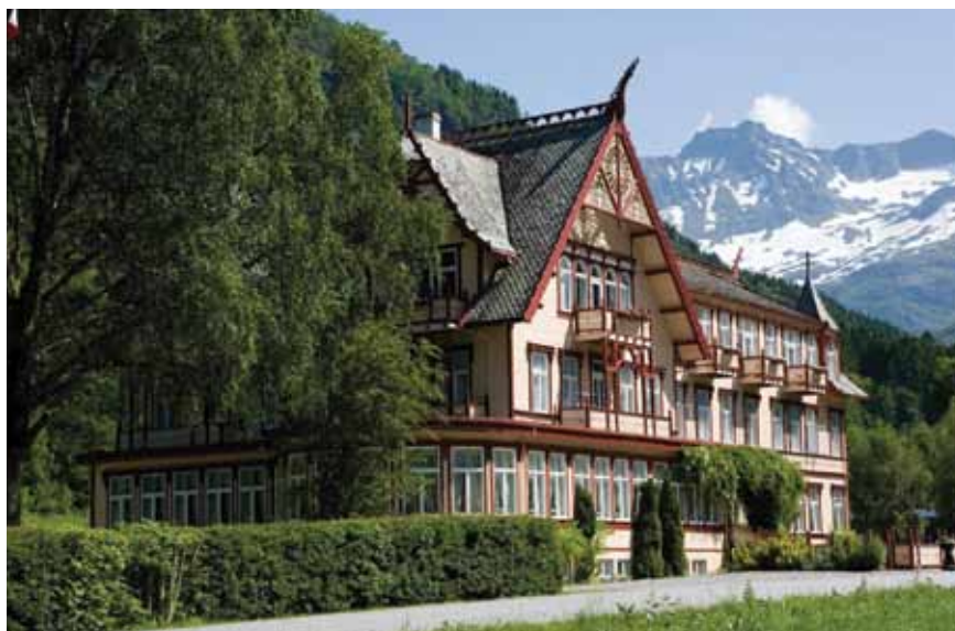
Sveiterstil. Hotel Union Øye, Norangsdalen, Sunnmøre (1891). Ferdighus levert av M. Thams & Co (Strandheim Brug). Foto: Magnus Nordstrand.
