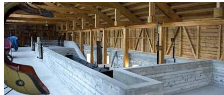
Storhamarlåven, Hamar (1969), Sverre Fehn. Foto: Trond Opsal, byggutengrens.no
