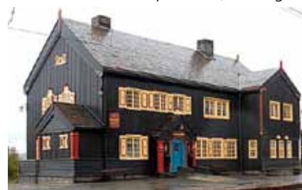
Hjerkinns stasjon, Dovrebanen (1921), Erik Glosimodt. Foto: Jernbaneverket
