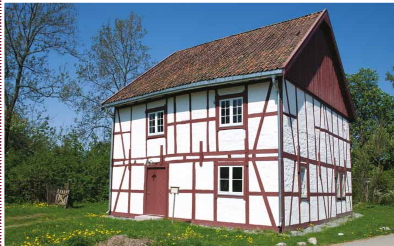
Brenneribygningen på Tveten gård er fra ca 1800, og er rehabilitert med midler fra Groruddalssatsingen.
