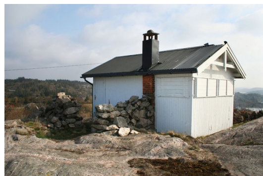
Hytta sett fra vest. Pipe i murstein trolig oppsatt av tyskerne under siste krig. Foto: Svein Berge
