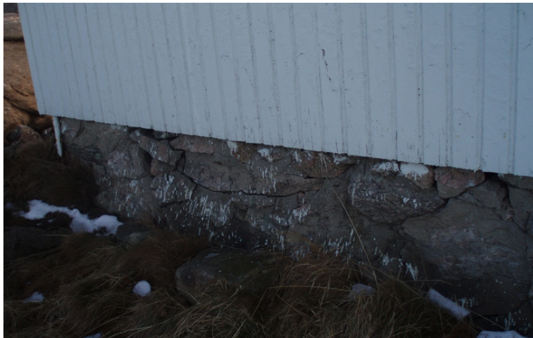
Kledning på sørsiden Foto: Svein Berge
