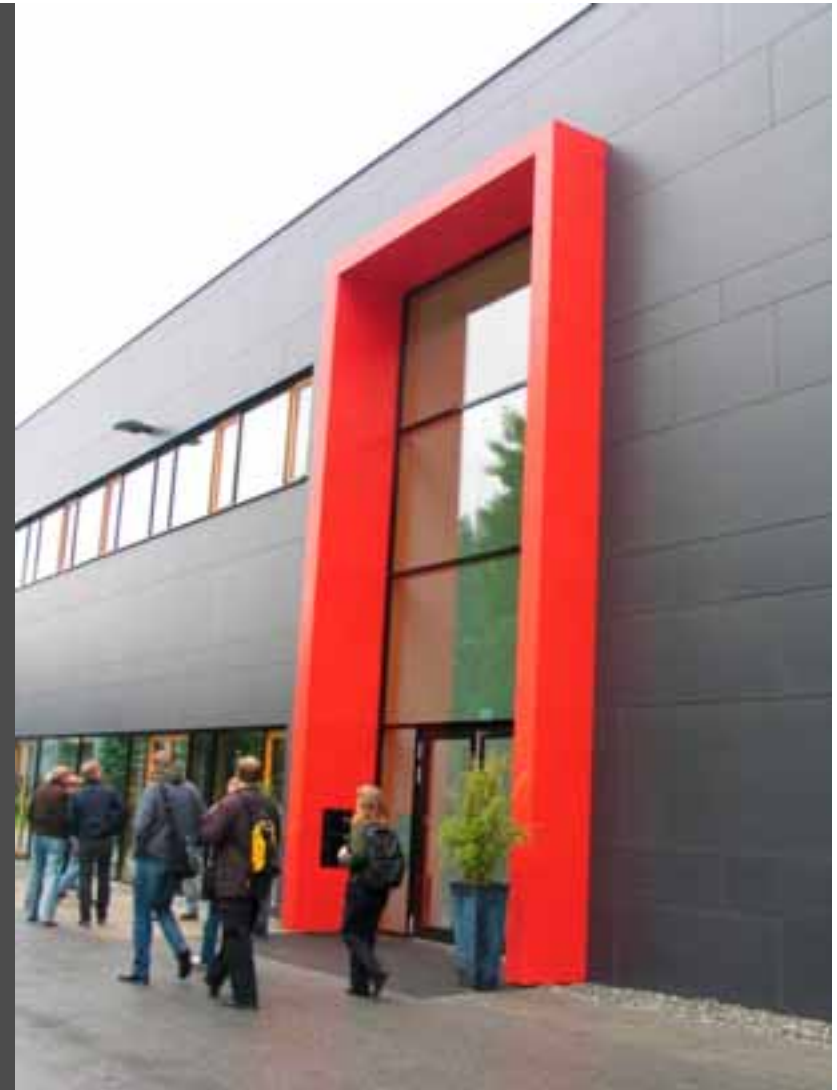
Wolfurt Drexel Weiss Industrial building, Østerrike. Arkitekt Gerhard Zweier
