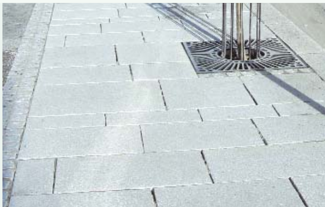
Natursteinsbelegg, bykarakter: Store rektangulære granittplater lagt i eit rettviskla leggemønster
