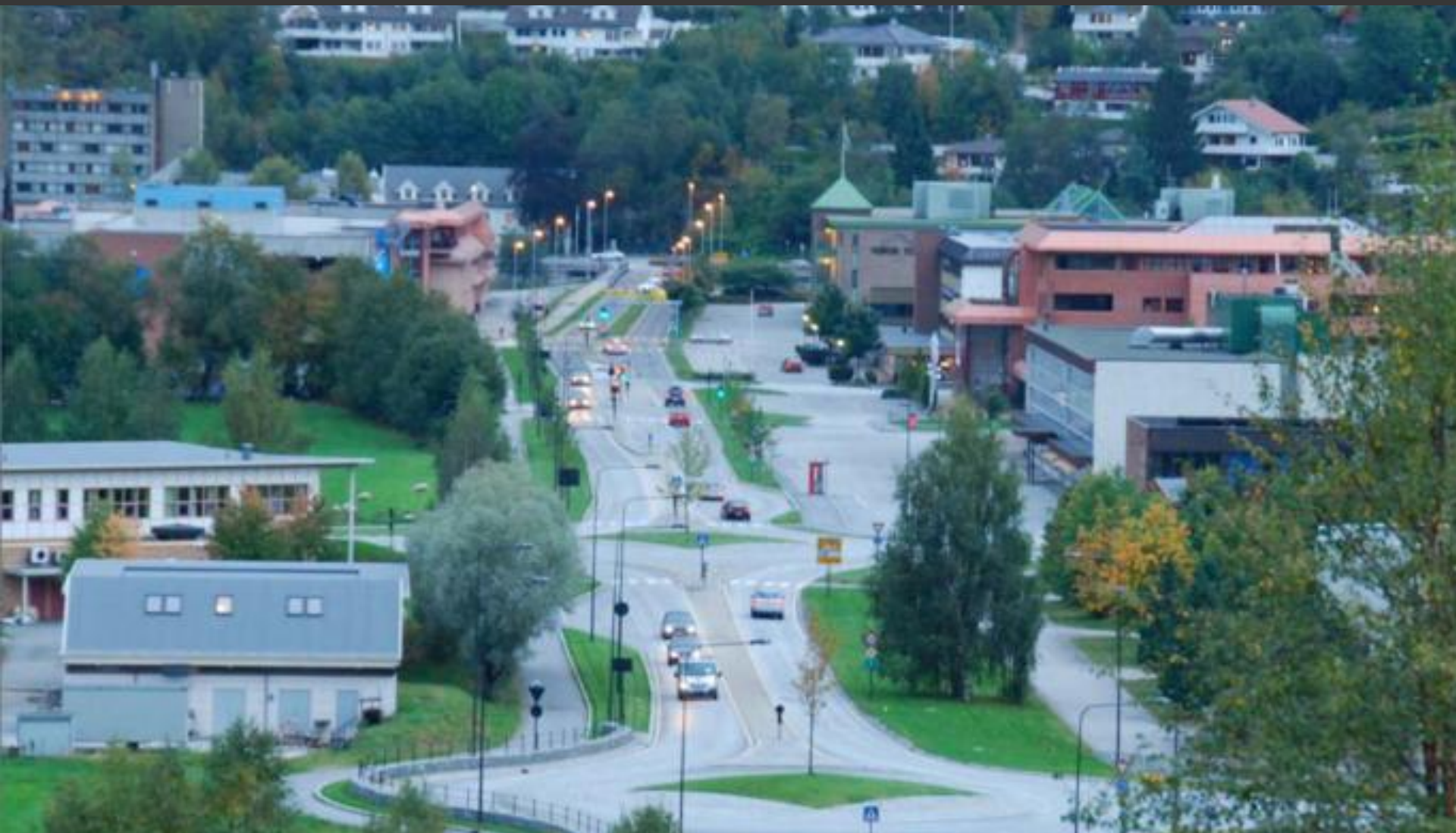
Riksveg 5 i Førde, Sogn og Fjordane, 53 m bred
