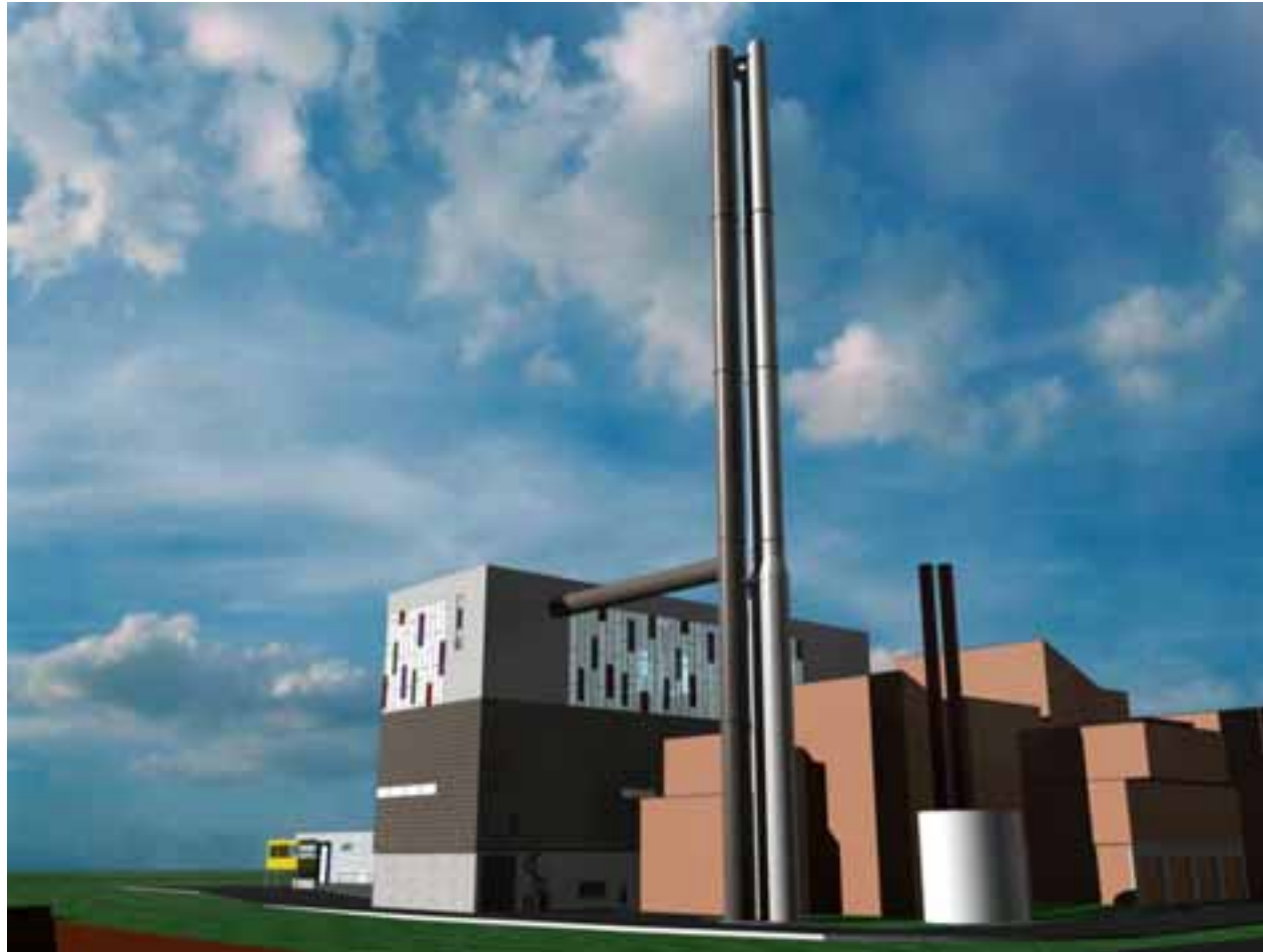
Nytt forbrenningsanlegg på Heimdal, TEV Fjernvarme
