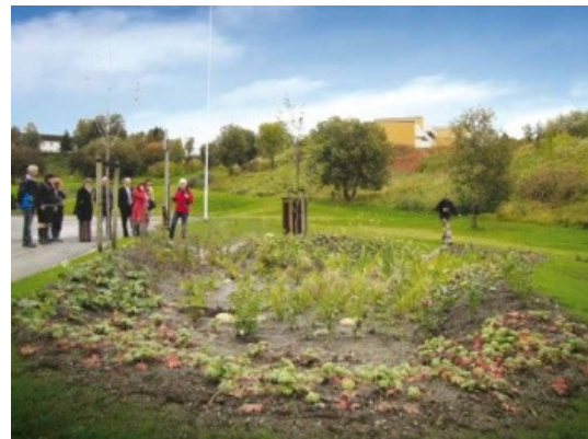
Demonstrasjon av bruk av regnbed for å hindre flom i tettbebygde områder.
