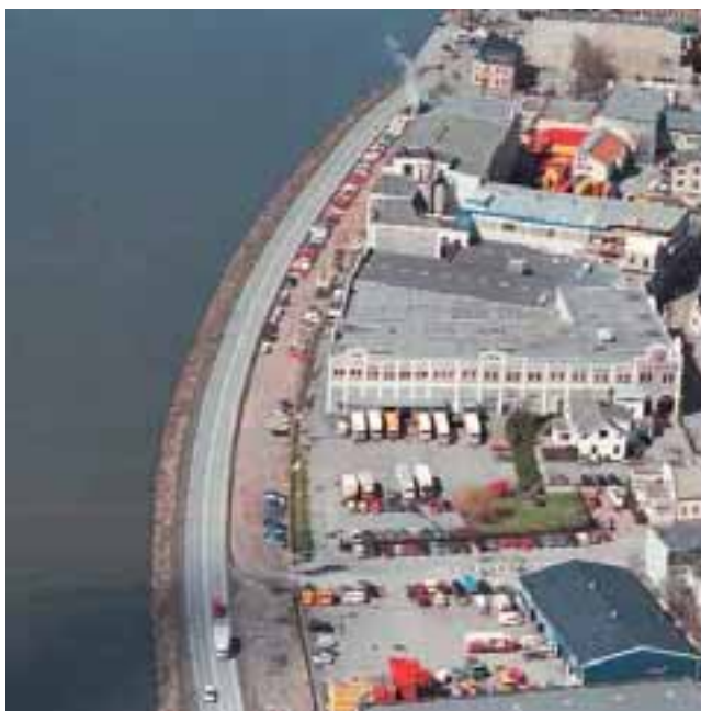
Strandveien ca 1985 og 2005
