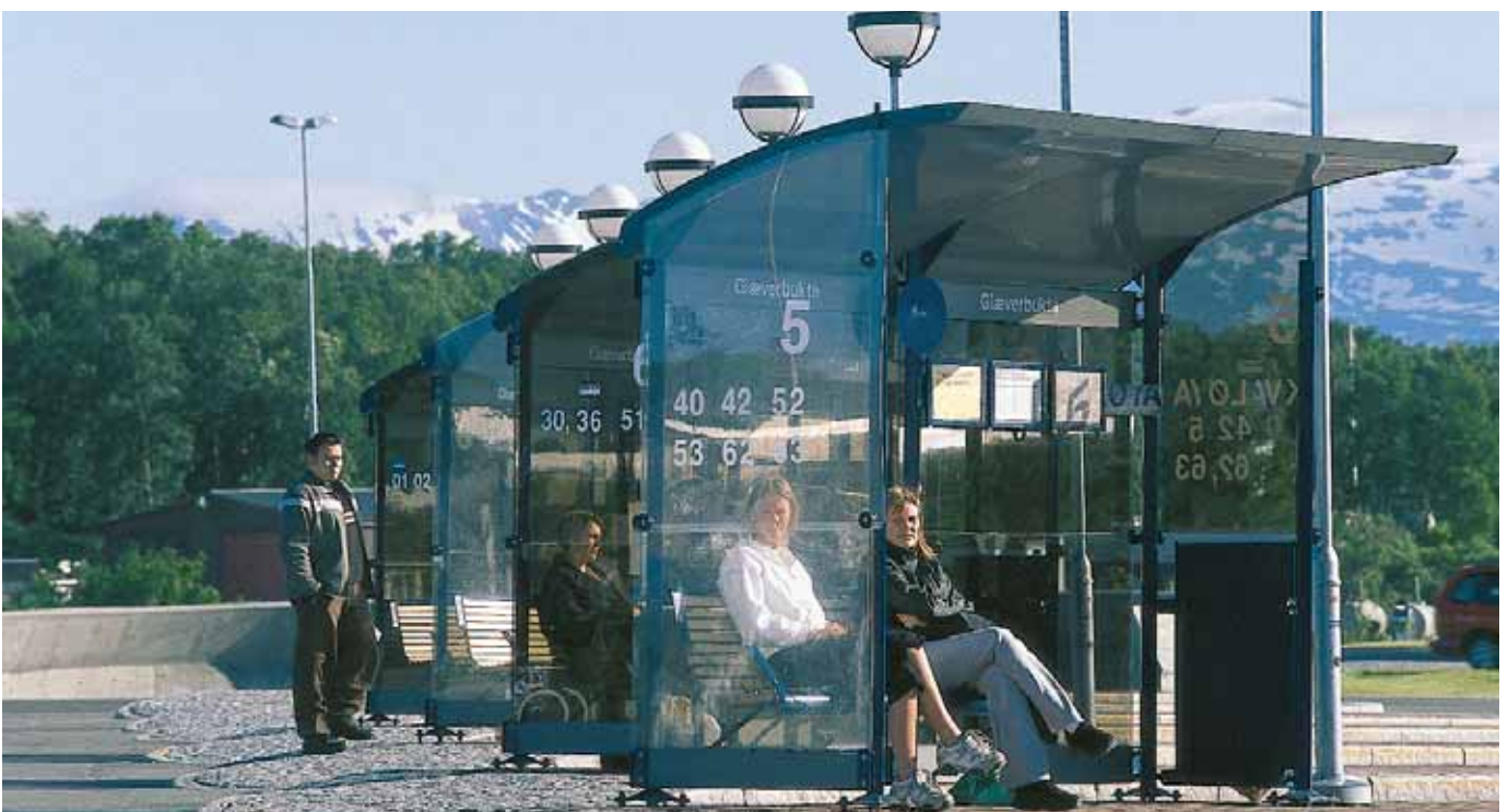
Værbeskyttet bussterminal på Glæverbukta Tromsø
