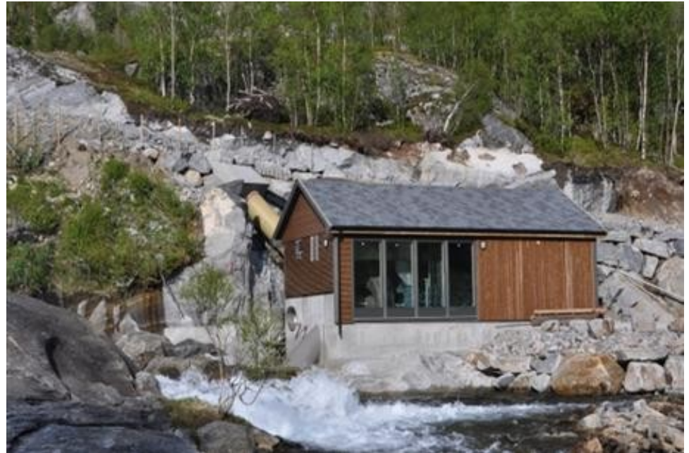
Kistafossen kraftverk Foto: Statkraft
