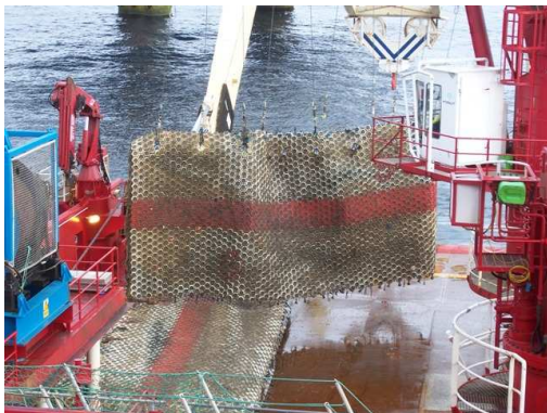
Figur 4-5. Fjerning av betongmatter som en del av fjerningsarbeidet ved Frigg.
