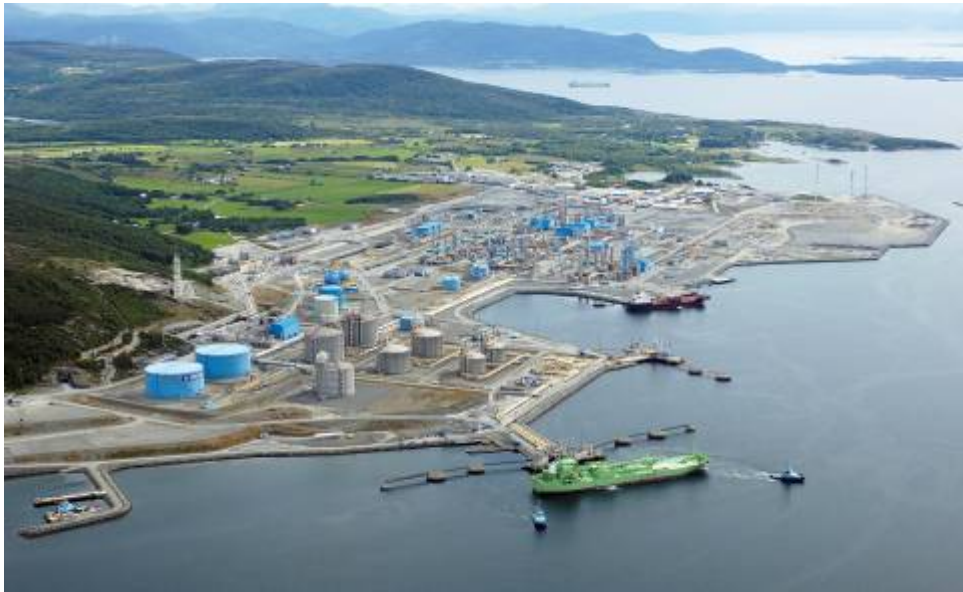
Figur 1-2. Kårstø gasbehandlingsanläggning i Rogaland
