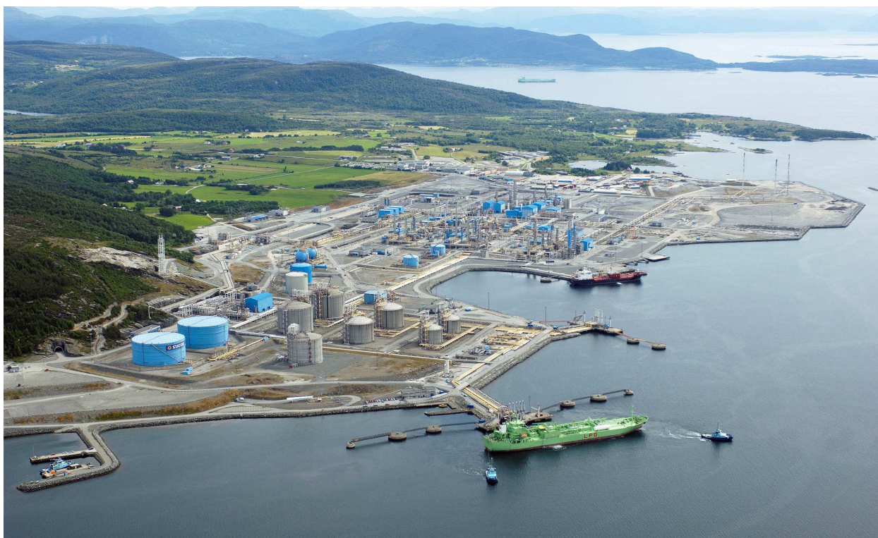
Figur 1-1. Kårstø gassbehandlingsanlegg i Rogaland
