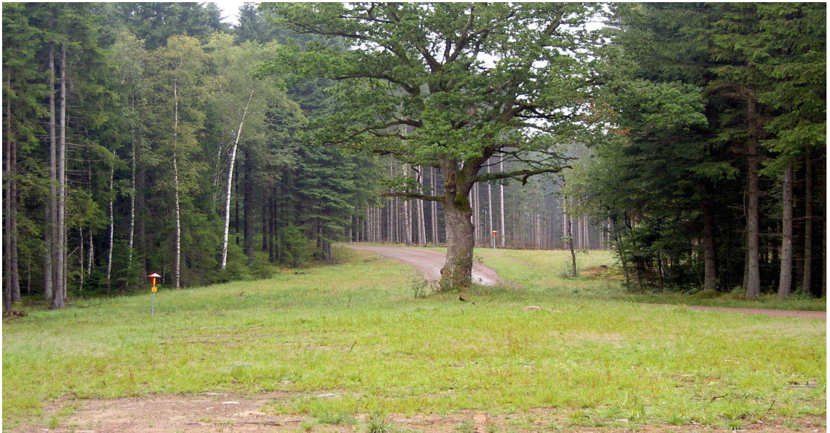
Figur 4-5. Eksempel på gjengravet anleggsgrøft hvor skiltene viser at det er gassrør i bakken
