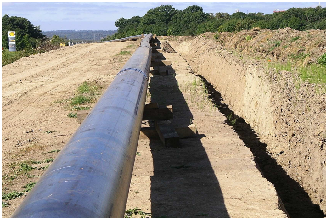
Figur 4-4. Eksempel på grøft for gassrør
