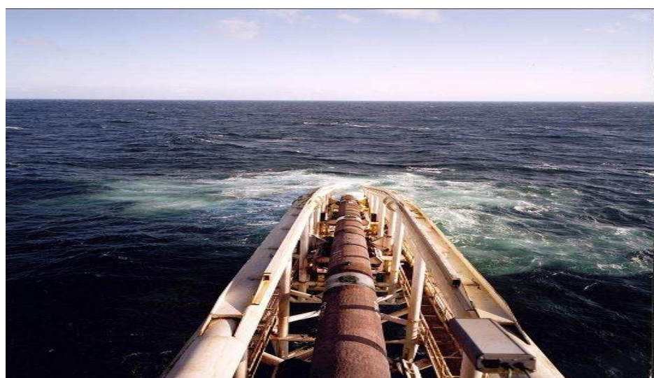
Figur 4-8. Eksempel på legging av gassrør offshore fra leggefartøy
