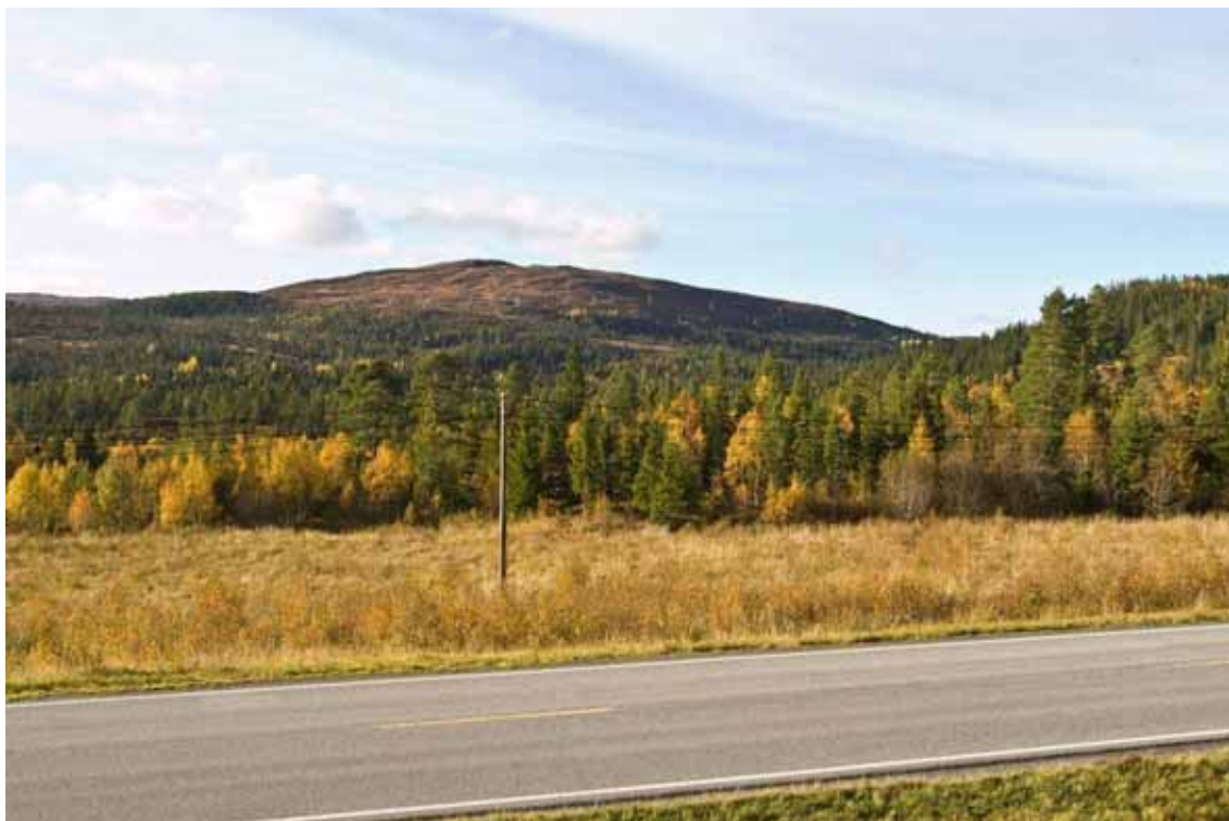
Figur 2.4 Eksisterende 66 kV-ledning forbi Marikammen i dagens situasjon.
