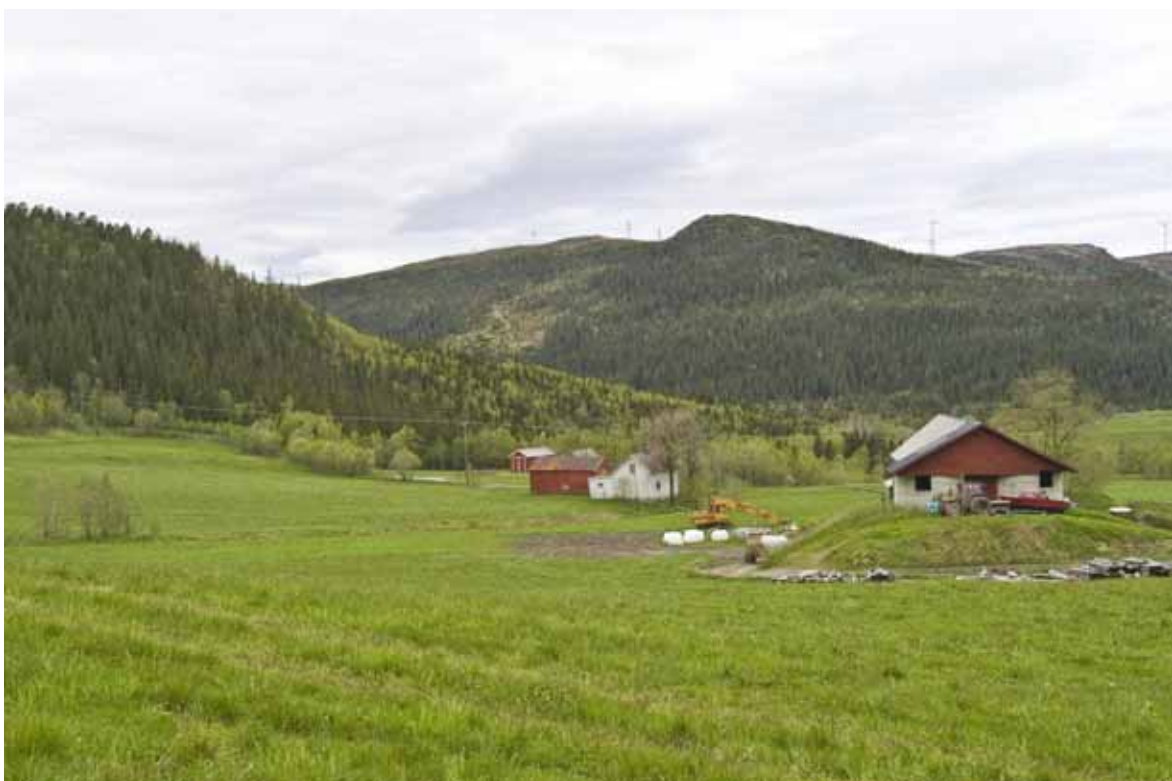
Figur 3. Ledningstrasé med dobbeltkurs 132 kV stålmaster sett fra Fagerdal, opprinnelig traséalternativ I. Foto og visualisering: Einar Berg, Ask Rådgivning.
