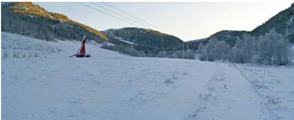
Figur 4. Ledningstrasé med dobbeltkurs 132 kV stålmaster sett fra Grovadalen, opprinnelig traséalternativ I. Foto og visualisering: Einar Berg, Ask Rådgivning.
