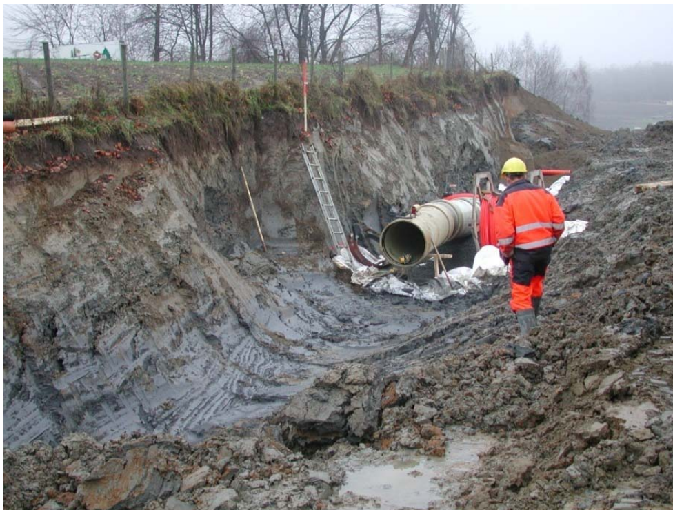
Figur 11. Graving av vannledning gjennom jordbruksområde i Lier.
