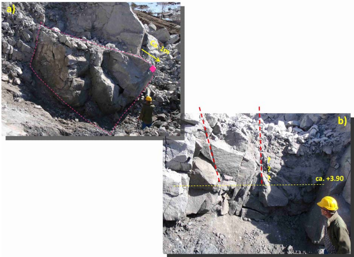
Figur 30 a) foto av blokk etter frigraving. b) foto av berget bak blokken etter at den var fjernet med borehull i stiplet rødt
