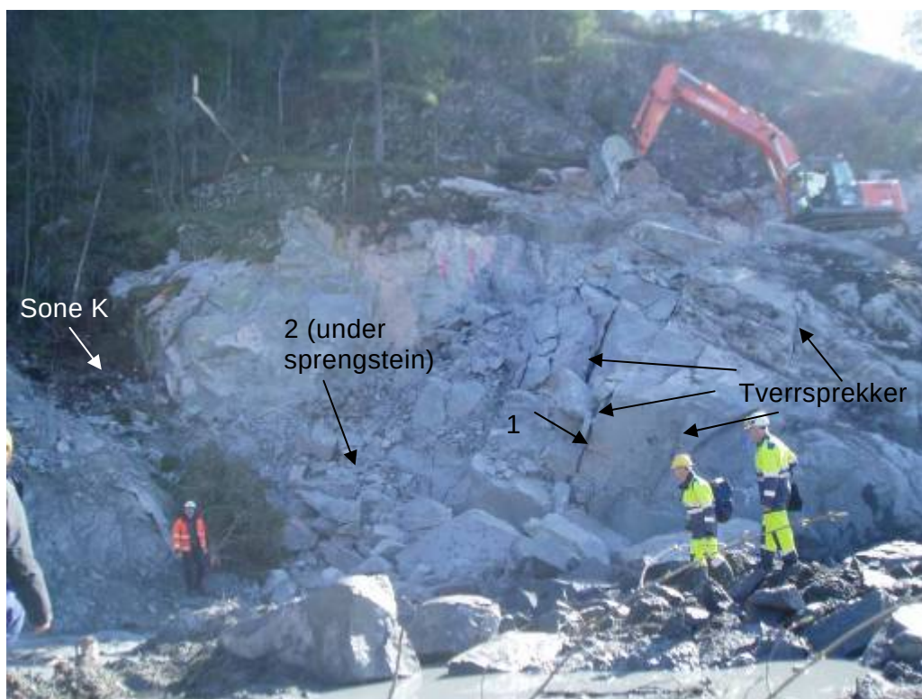
Foto 1. Sprengstein fra salve 19 før utgraving. "1" og "2" er spesielt markerte slepper.
