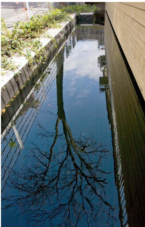
Overvannskanal i Chr. Krohgs gate, Oslo. Landskapsarkitekt: Dronninga landskap. Foto: Adam Stirling
