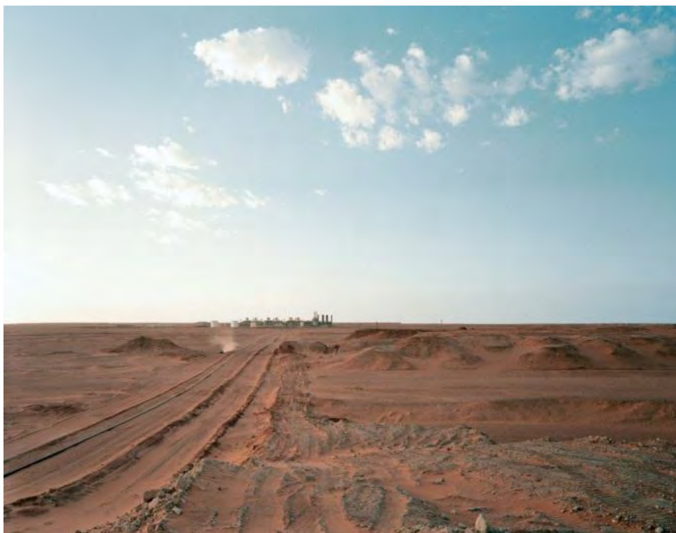
Gassproduksjonsanlegget i In Amenas. Foto: Manfred Jarisch, Statoil
