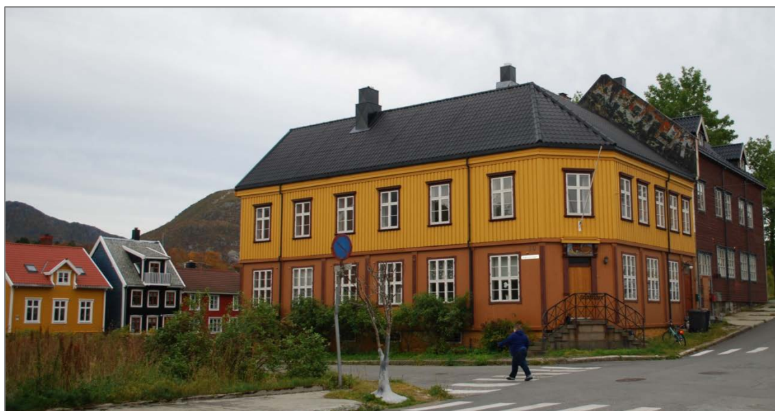
Figur 4: Eldre bygningsmiljø, Kabelvåg, Vågan kommune. Foto: Kristin Os, NIKU.
