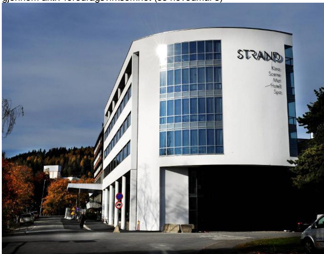
Bilde fra Oppland Arbeiderblad.
