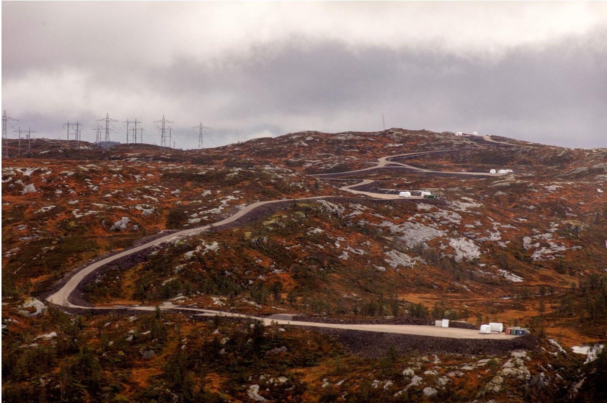
Figur 8: Installasjoner i den nordlige delen av Tonstad vindkraftverk. Området framstår nå som et rent industriområde
