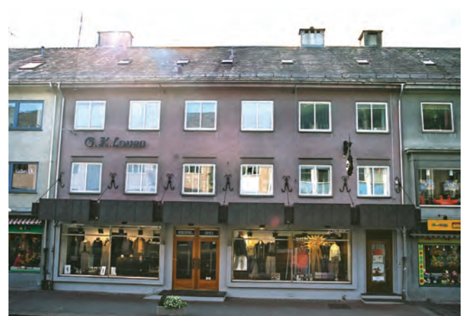
Mineralitt pussen har grånet over tid.
