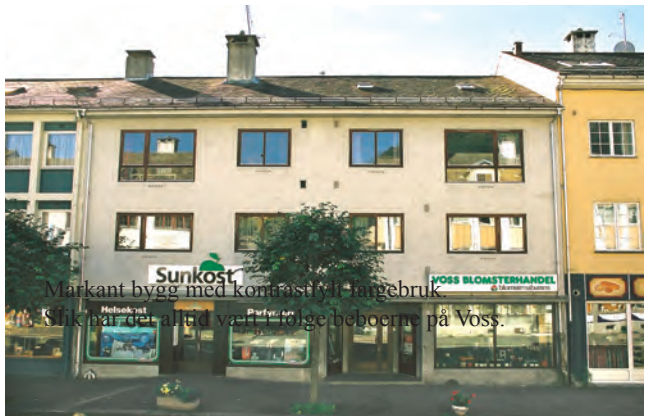
Mineralittpussen finnes i ulike farger i tråd med en typisk 50-tallspalett.
