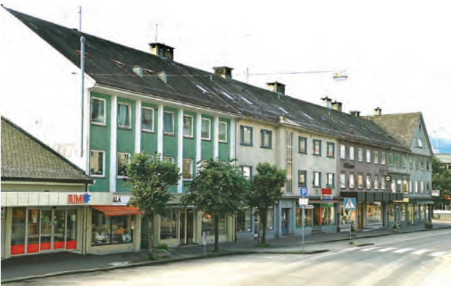
Mineralitt puss og platekledninger fra 50-tallet
